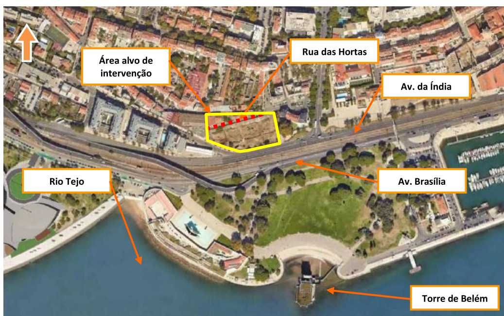
Figura 1 – Vista aérea do local de intervenção (imagem retirada do Google Earth).
