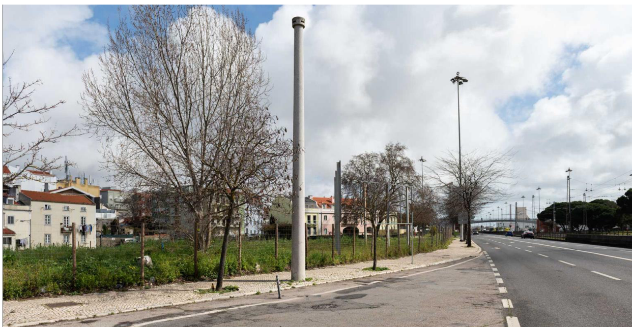
Avenida da Índia, vista para Nascente. Frente Sul do terreno.
