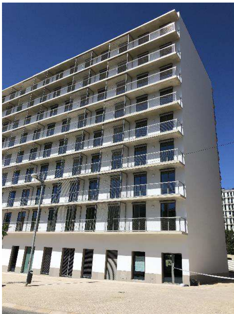
Fachada principal do edifício
