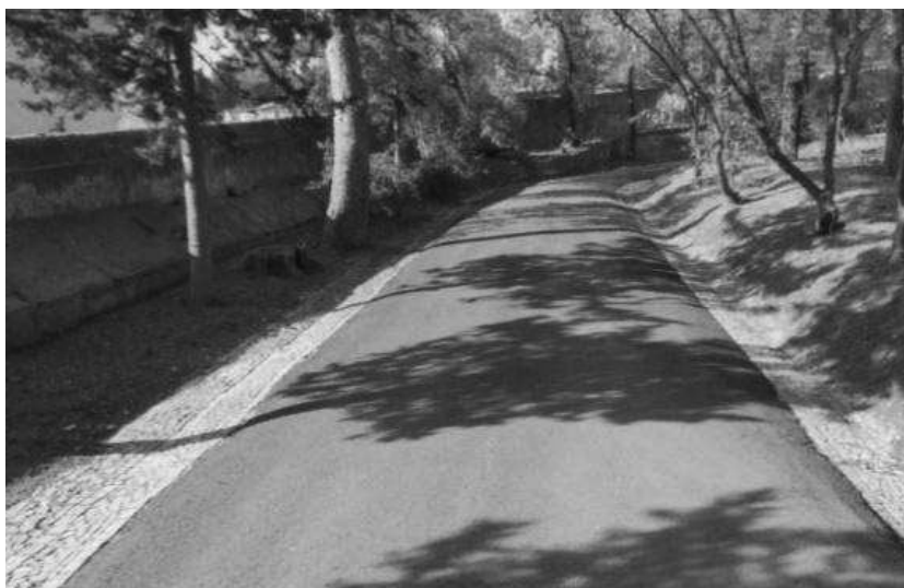
Figura 64 – Pavimento em camada de desgaste em betuminoso.
