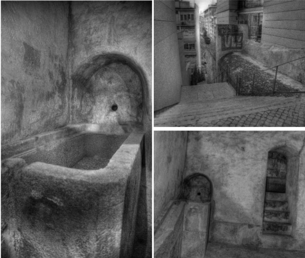
Figuras 59, 60 e 61 – galeria e claraboia que sobreviveram à construção da Avenida Infante Santo.
