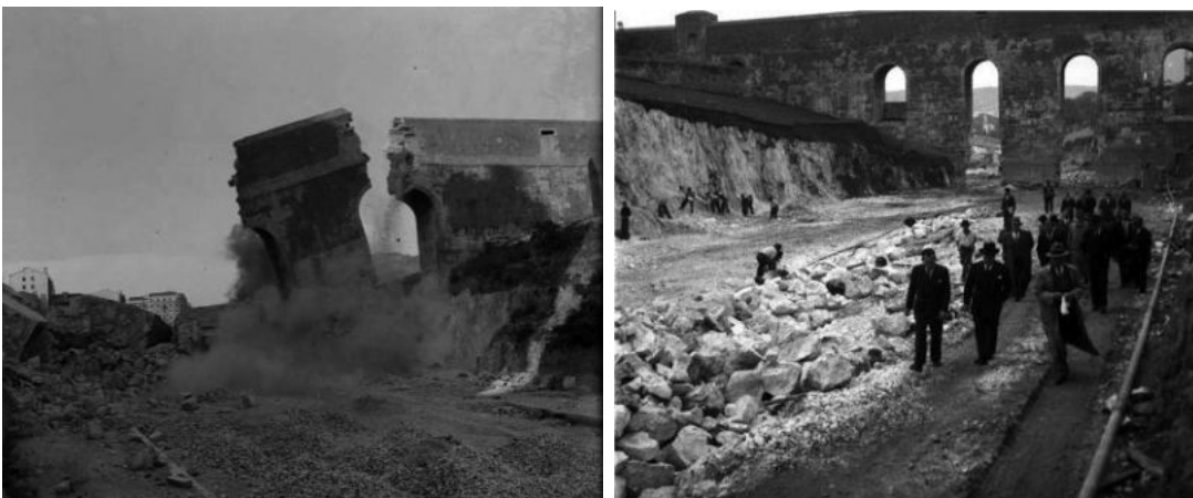
Figuras 62 e 63 – obras para a construção da Avenida Infante Santo.
