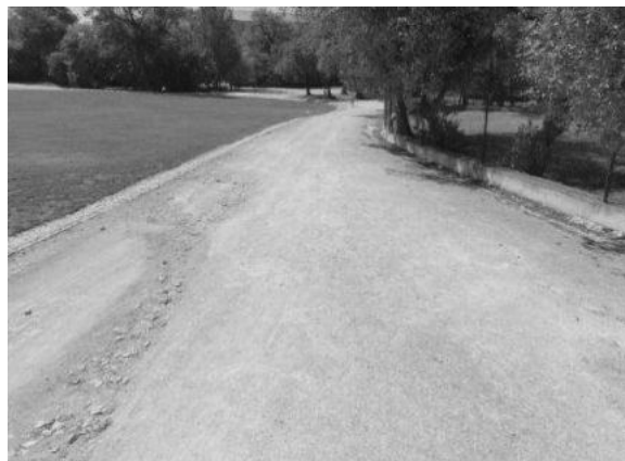
Figura 67 – Pavimento em saibro com sulco
