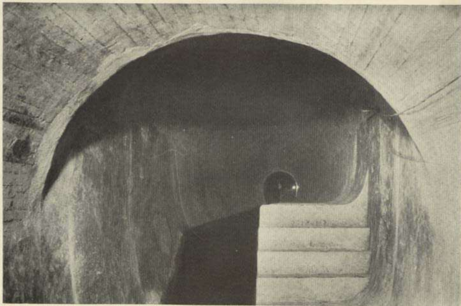
UM DOS «DEGRAUS» DO GRANDE COLECTOR, DESCRITOS NO TEXTO
