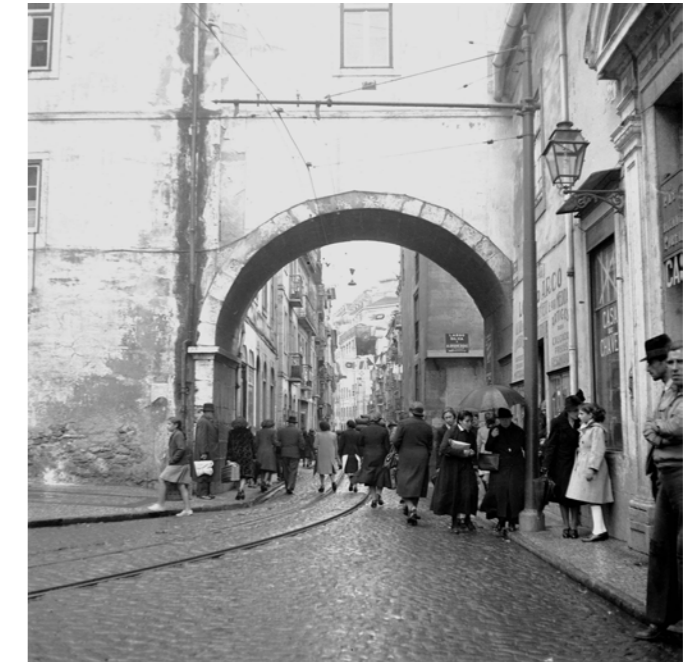
Perspetiva da face poente do Arco do Marquês de Alegrete anterior à demolição do palácio, cuja fachada lateral se vê à direita. Foto Benoliel. AML/AF, JBN 4011
