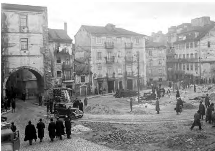
Fig. 15 - Arco do Marquês de Alegrete depois da demolição do palácio, Lisboa, 1947. Foto Eduardo Portugal. AML/AF
