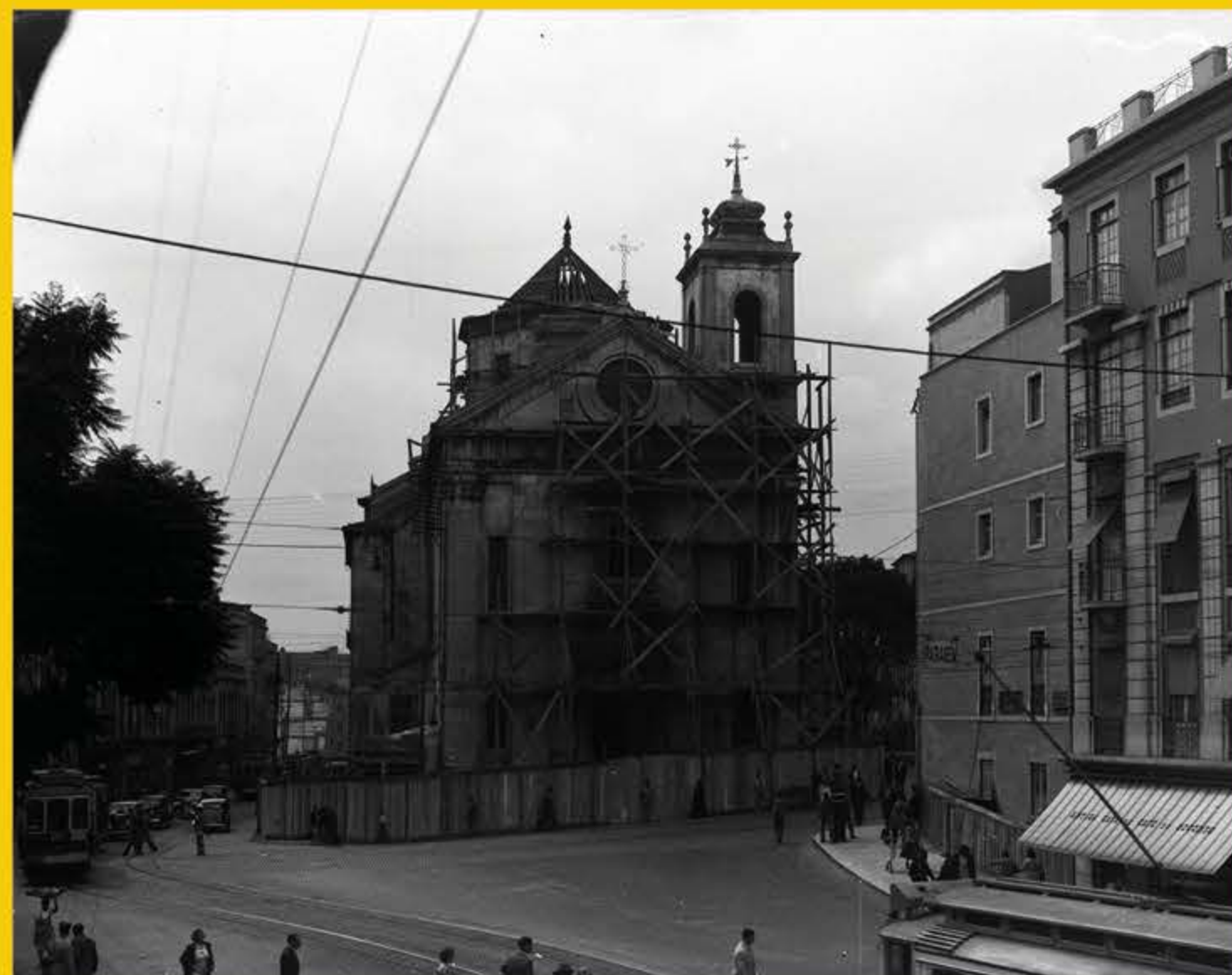
Igreja Nossa Senhora do Socorro, início da demolição, 1949. Eduardo Portugal.
