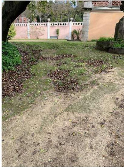
*Figura 66 – Zona Plana em saibro estabilizado com pavimento degradado.*
