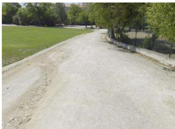
Figura 67 – Pavimento em saibro com sulco
