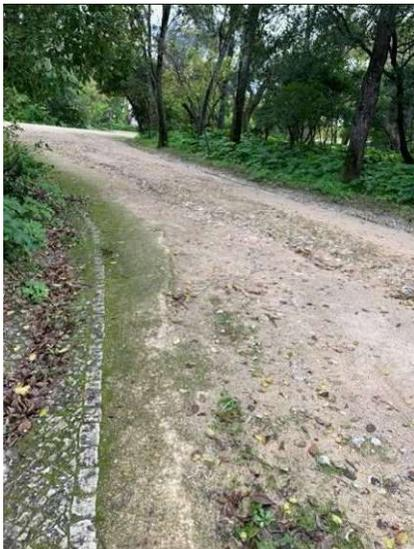
*Figura 65 – Pavimento em saibro estabilizado com sulco central (a valeta não cumpre a função).*
