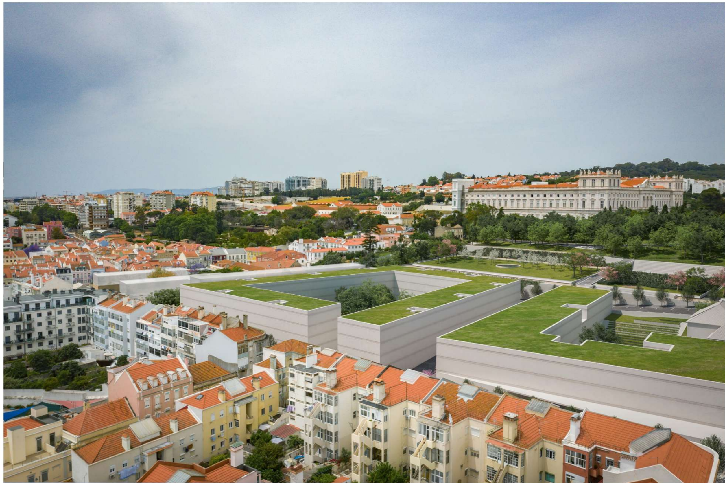
Vista geral da intervenção
