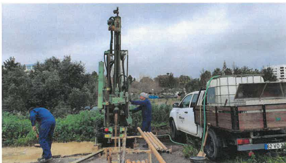
Figura 9 – Equipamento de furação posicionado na sondagem S1
