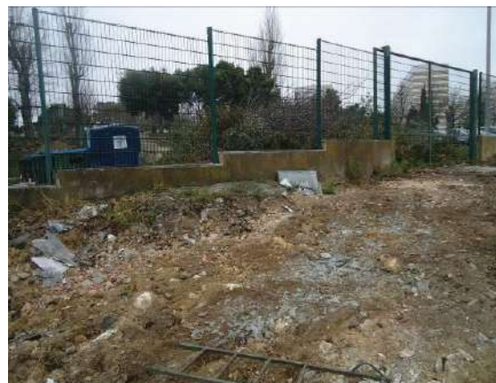
Figura 4.12 - RCD no setor Noroeste do terreno, após desmatamento
