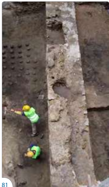
Imagem 3 Vista dos trabalhos junto a troço da muralha. Artur Rocha, 2010.
