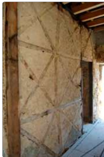
Imagem 11 Estrutura interior em gaiola pombalina. Maio 2012
