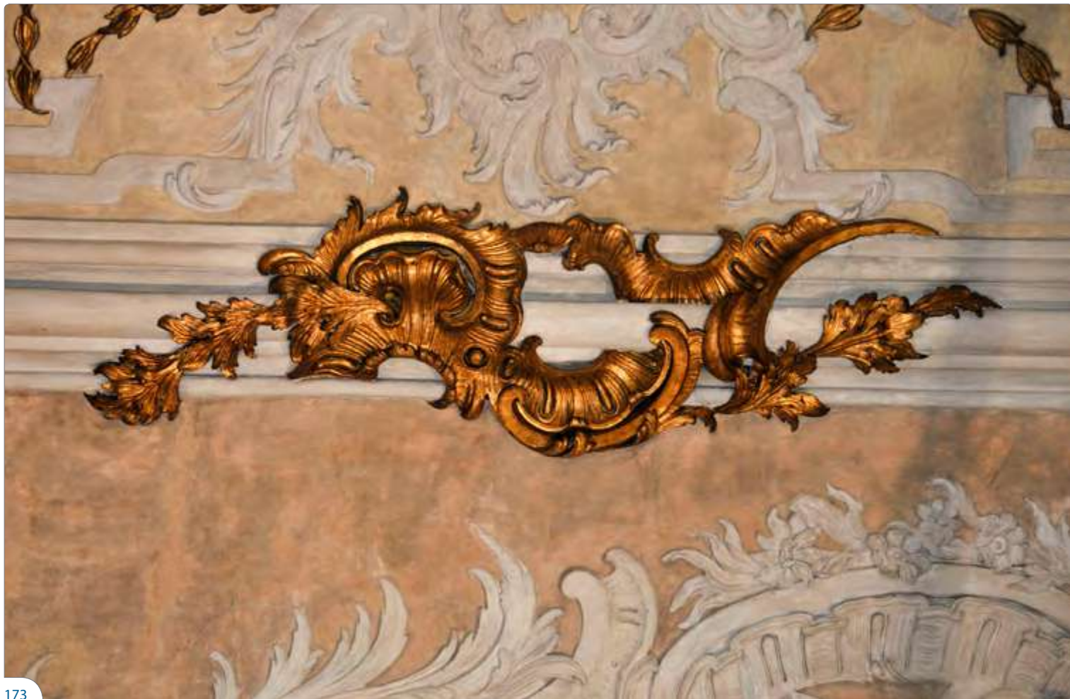
Imagem 6 Pormenor decorativo da abóbada da nave. Fotografia de Tiago Antunes.
