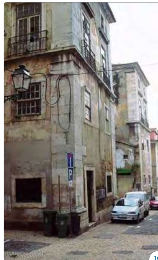
Imagem 1 Vista do edifício do Palácio dos Lumiares a partir do cruzamento da Rua do Diário de Notícias com a Travessa da Boa Hora.
