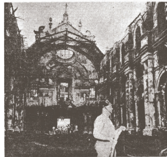
O aspecto desolador do templo, de que só restam as paredes
