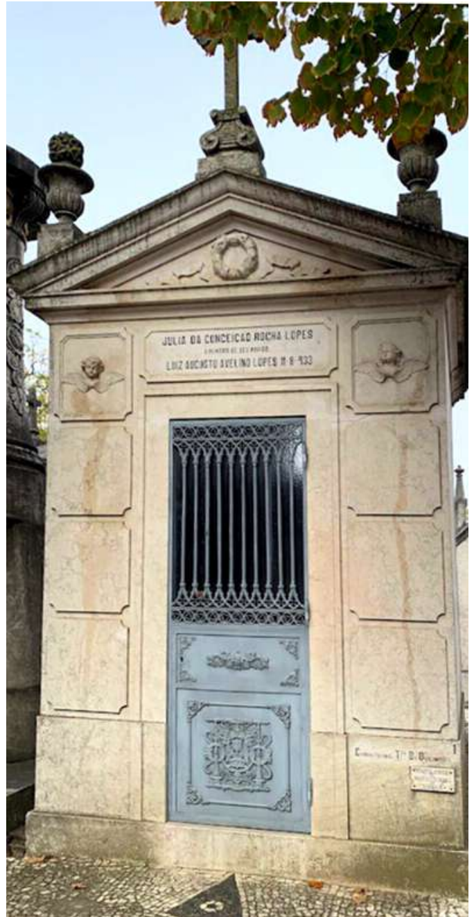
Jazigo N.º 1 - Alto de São João, Rua 1 esqº Meia Laranja (junto à capela)
