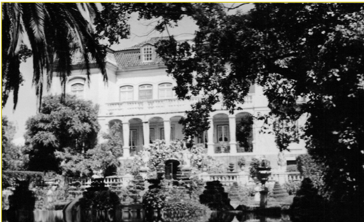
Figura 9 Vista da fachada sul com jardim de estilo renascentista, sendo propriedade do professor doutor Fausto Lopo de Carvalho. Fotografia de Patrícia Lopo de Carvalho Madeira Rodrigues.
