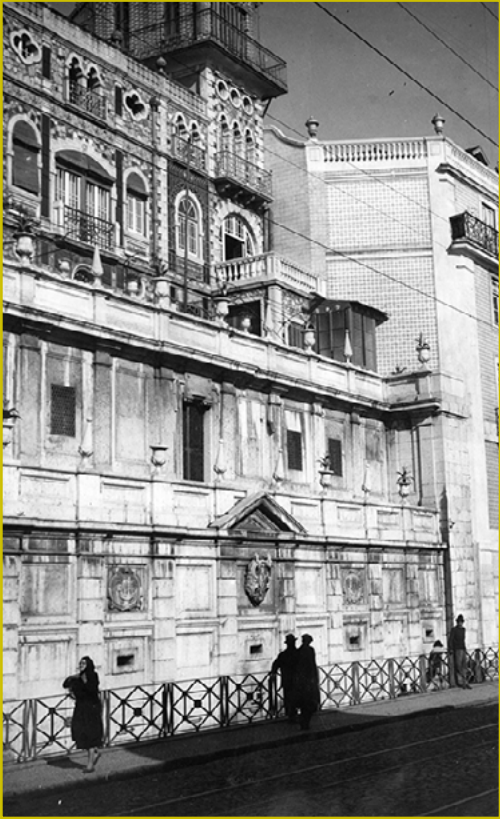
Figura 1 Chafariz d'el-rei encimado pelo palácio construído no século XX, 1945. AML, André Salgado, PT/AMLSB/SAG/000027
