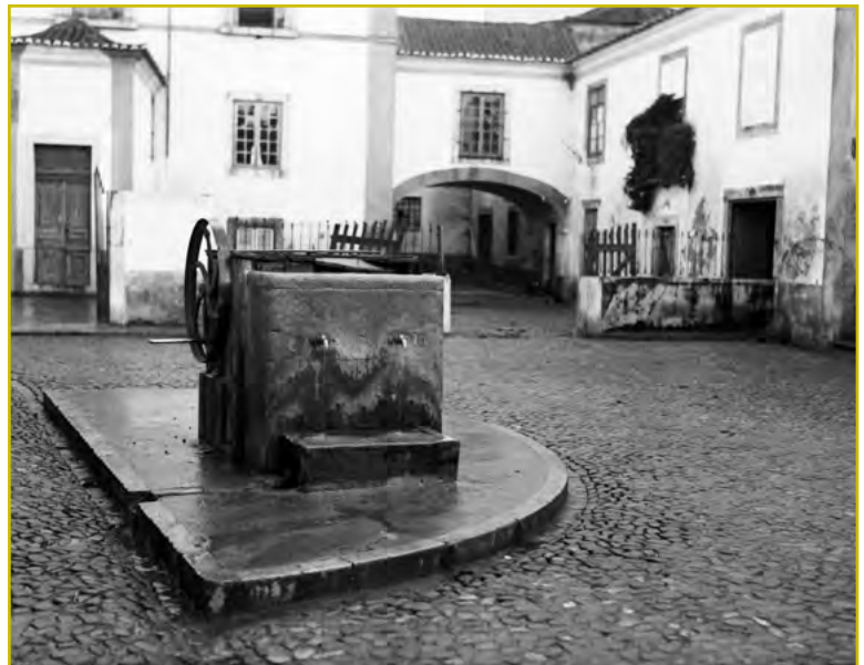
Figura 2 Vista do largo do Poço do Concelho, com o palácio da família Cabedo ao fundo. Coleção Américo Ribeiro, 1939. Arquivo Fotográfico Américo Ribeiro SMBM | DCED | Câmara Municipal de Setúbal. AR896.
