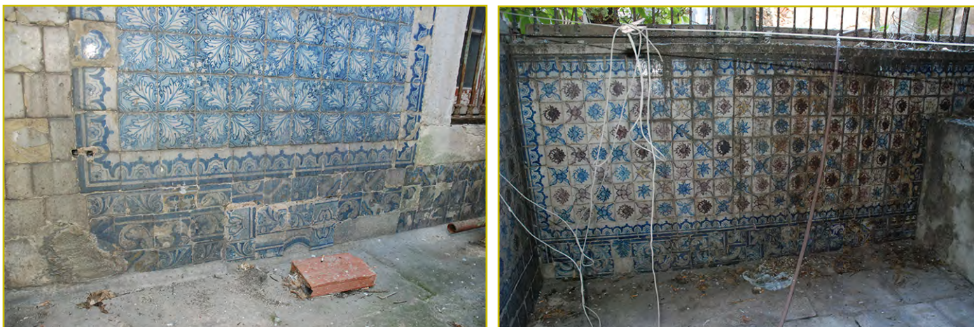
Figuras 13 e 14 Terceiro momento do revestimento azulejar: reaplicação do padrão seiscentista P-67, eventualmente proveniente do Convento de Cristo de Tomar, propriedade da família Costa Cabral, com cercadura pombalina. Padrões pombalinos com a mesma cercadura. Este terceiro momento é datável da segunda metade do século XIX mas ainda tem em conta a cota mais elevada do pavimento. Fotografias do autor, 28-11-2013.
