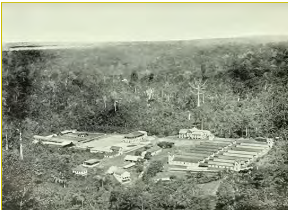
Figura 20 Vue panoramique du siège de l'administration de la plantation Boa Entrada, à S. Thomé 49 .
