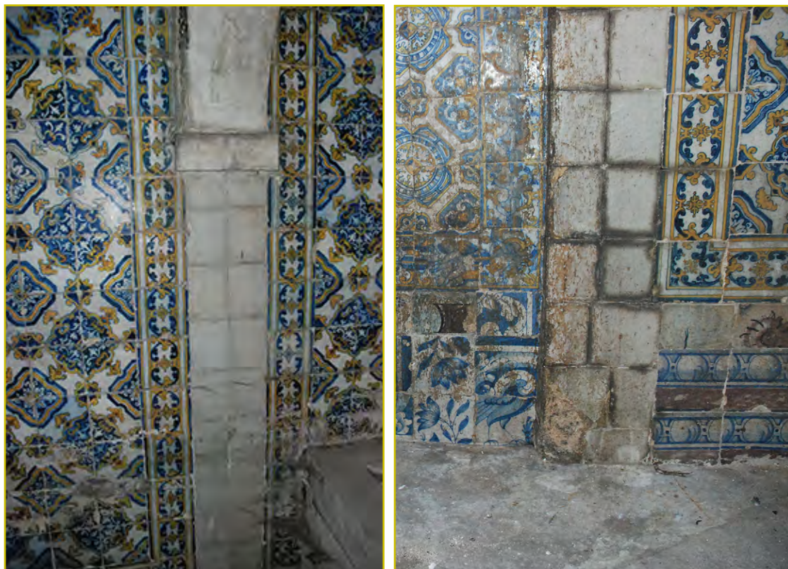
Figuras 9 e 10 Primeiro momento do revestimento azulejar: azulejos brancos e lisos, típicos da segunda metade do século XVI, utilizados em todo o país em revestimentos enxaquetados. Estes azulejos assumem a imagem de pilastras prolongando a linha do arco até ao pavimento em pedra. São assim associáveis à arquitetura do espaço, em particular aos arcos e ao pavimento. São os únicos que se relacionam com o pavimento de pedra. Fotografias do autor, 28-11-2013.
