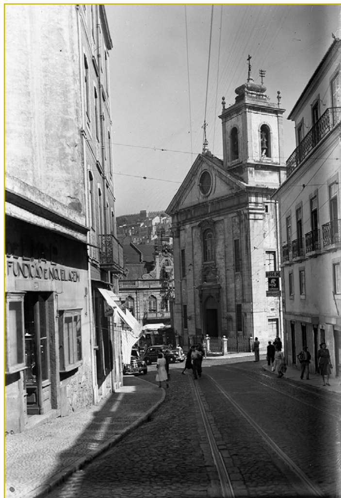
Figura 13 Igreja do Socorro antes da demolição, 1949. Fotografia de Eduardo Portugal. AML, PT/AMLSB/POR/019589.
