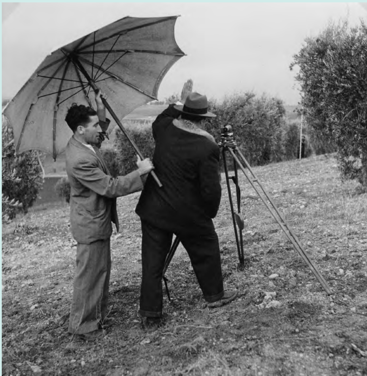
Operações de topografia tendentes a implantação de "terraços", Herdade da Pedreira Elvas 1954 PT/AMLSB/ART/021542
