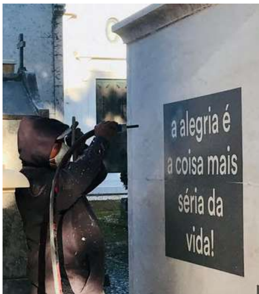
Gravação com jato de areia
