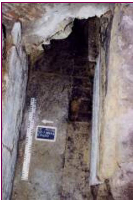
Figura 4 Rua/Beco dos Cabriteiros, conduta pública de 2.ª ordem.
