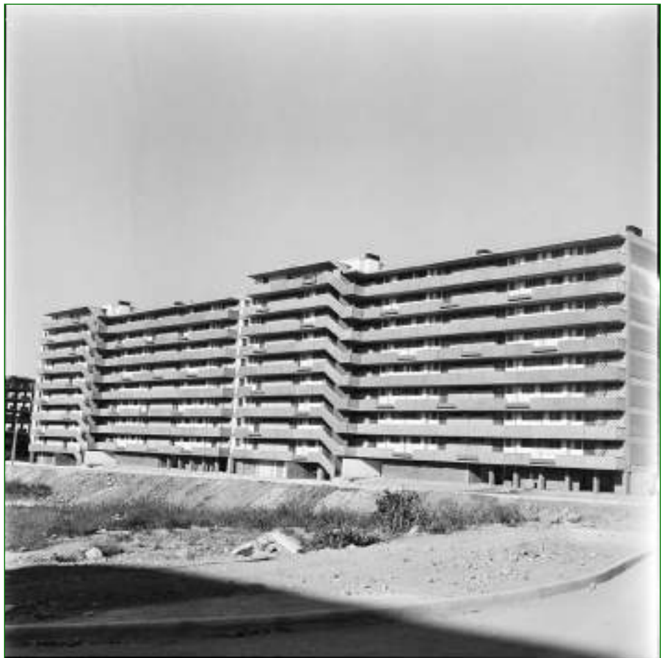
Figura 11 Edifício de Gandra, Calhoz, Coutinho Raposo e Costa Martins, fotografia de Augusto de Jesus Fernandes, 1966. AML, PT/AMLSB/CMLSBAH/PCSP/004/AJF/001817.
