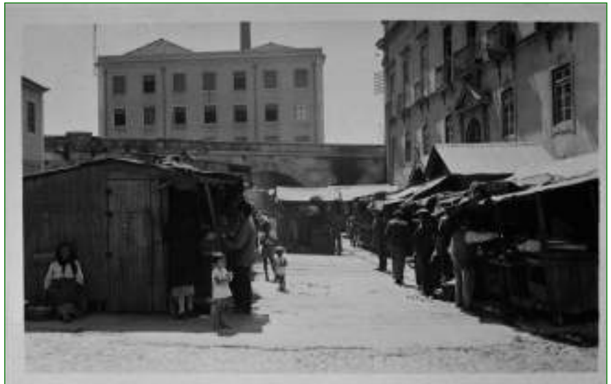
Figura 10 Largo do Marquês de Nisa, com o edifício da Fábrica de Moagem a Vapor Aliança ao fundo da imagem, Eduardo Portugal. 1939. AML, PT/AMLSB/CMLSBAH/PCSP/004/EDP/001360.
