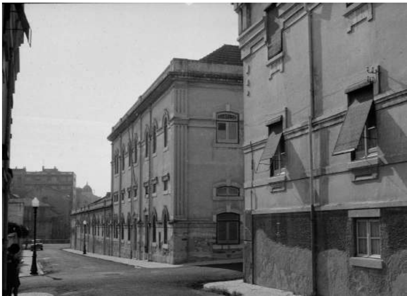
Bairro do Arco Cego, edifício do Arquivo Municipal de Lisboa na esquina das ruas Nunes Claro e Ladislau Piçarra, negativo de gelatina e prata em acetato de celulose, Arnaldo Madureira, 35 mm, 1969. Arquivo Municipal de Lisboa, PT/AMLSB/CMLSBAH/PCSP/004/ARM/006634.
