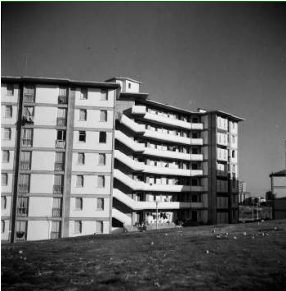
Figura 10 Edifício de Figueiredo e Lobo, fotografia de Vasco Gouveia de Figueiredo, 1967. AML, PT/AMLSB/CMLSB/PCSP/004/VGF/001227.
