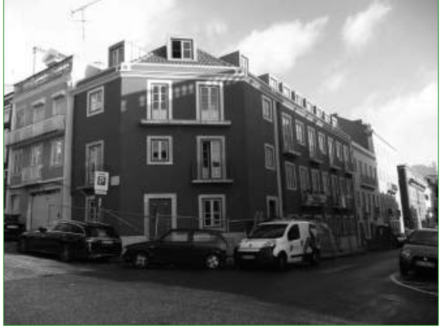
Figura 20 Ampliação na Rua das Praças em 2019. Fotografia da autora.
