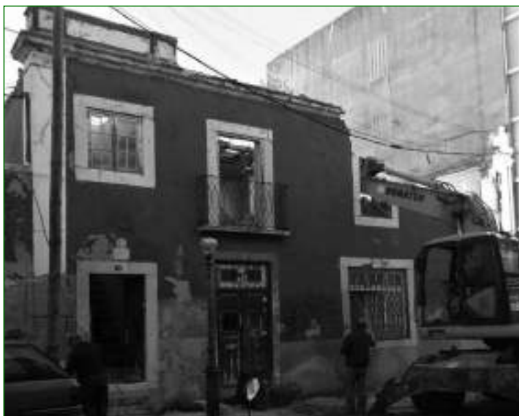
Figura 4 O mesmo edifício em demolição em 2017. Fotografia da autora.
