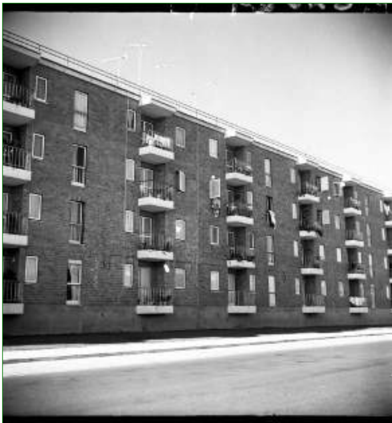
Figura 5 Edifício de Braula Reis e Matoso, fotografia de Vasco Gouveia de Figueiredo, 1968. AML, PT/AMLSB/CMLSBAH/PCSP/004/VGF/001271.
