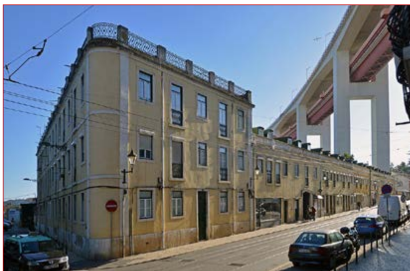
Figura 1 Vila da Companhia de Fiação de Tecidos Lisbonense. Os edifícios de 1873, formam a correnteza de dois pisos, em segundo plano. O prédio de esquina, em primeiro plano, tem projeto de 1890 36 . Fotografia de João Veríssimo.
