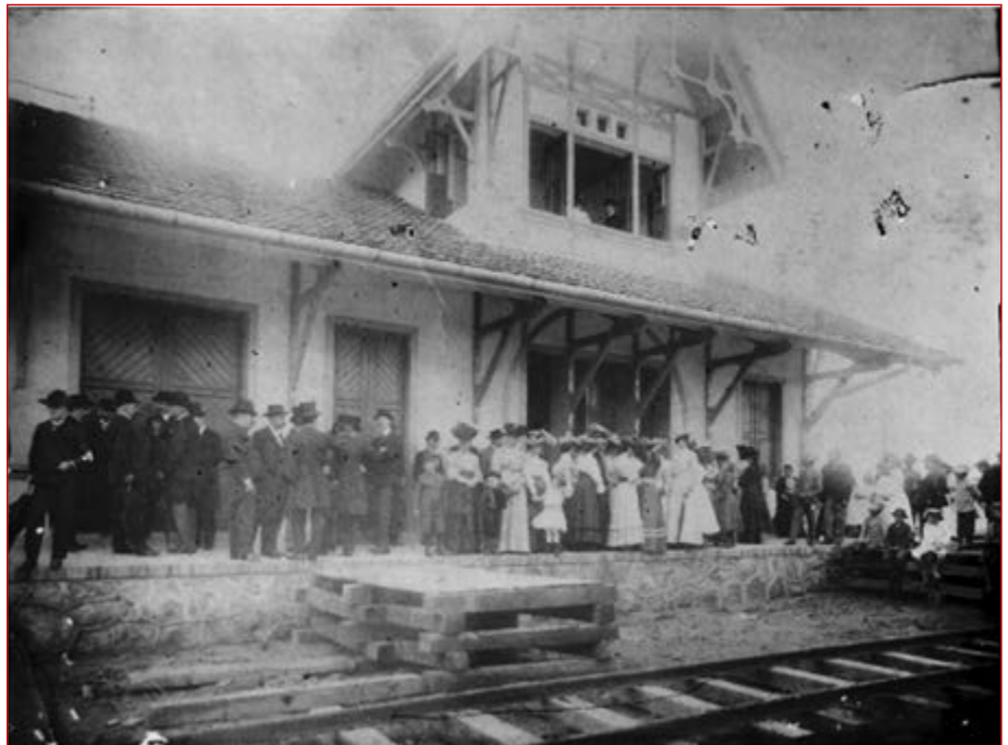
Figura 1 Inauguração da Estação e do Ramal Ferroviário Joinville - São Francisco do Sul, 1906. Acervo do Arquivo Histórico de Joinville.
