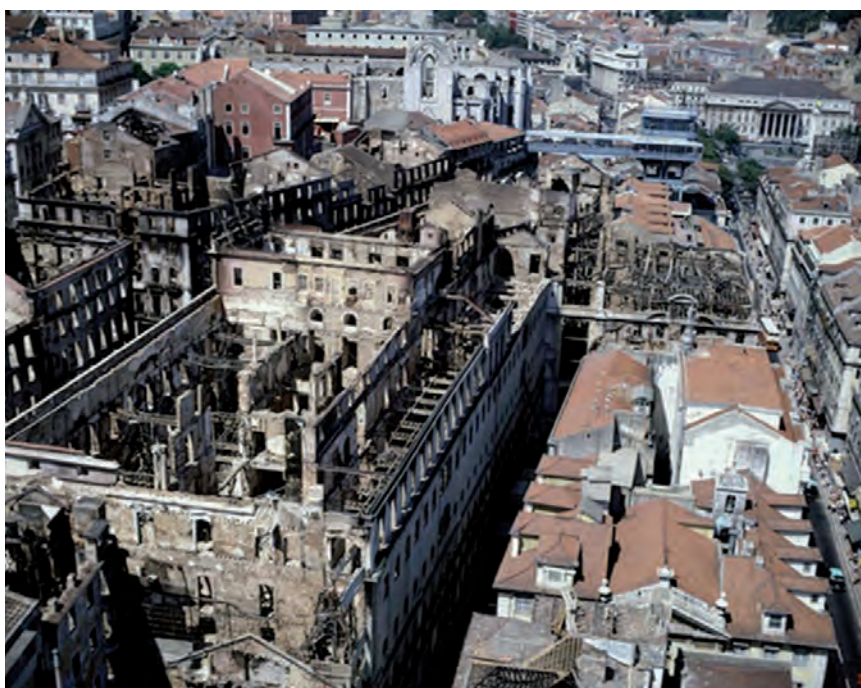
Figura 45 – Perspetiva aérea dos edifícios destruídos pelo incêndio
