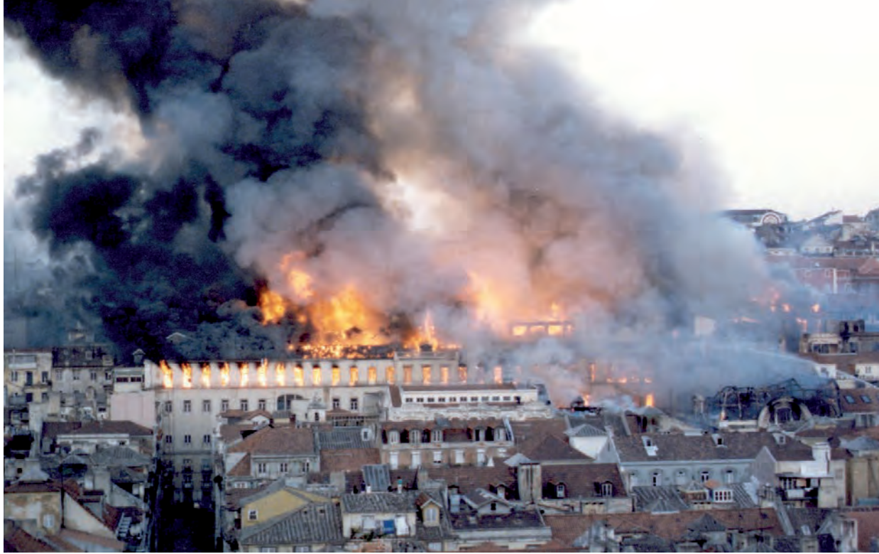
Figura 25 – Pisos superiores e cobertura dos Armazéns do Chiado completamente tomados pela chamas
