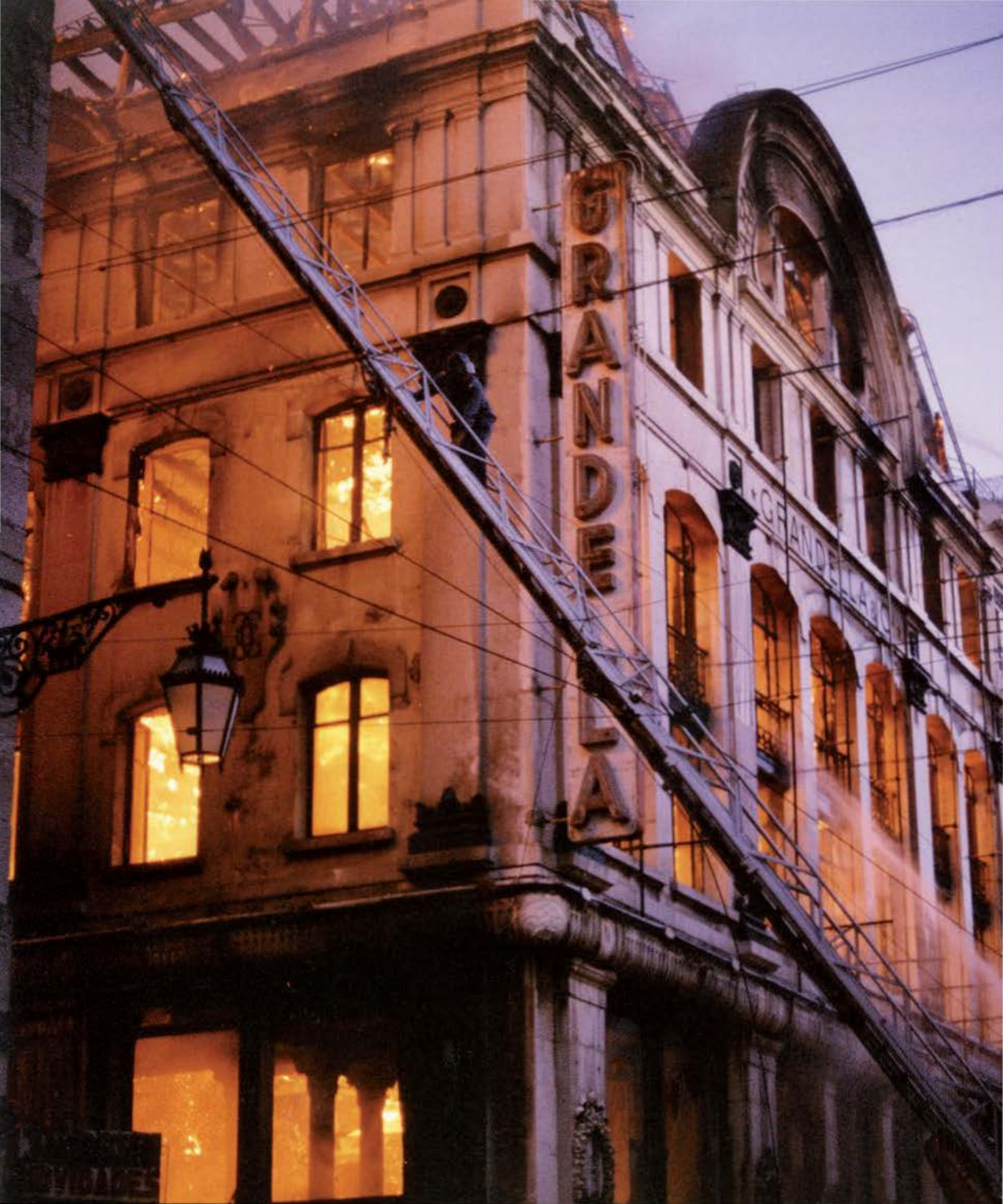
Figura 15 – Veículo Escada arvorado entre o traçado aéreo dos elétricos no cruzamento da Rua Áurea com a Rua da Assunção. É possível verificar o interior do Grandella completamente em chamas
