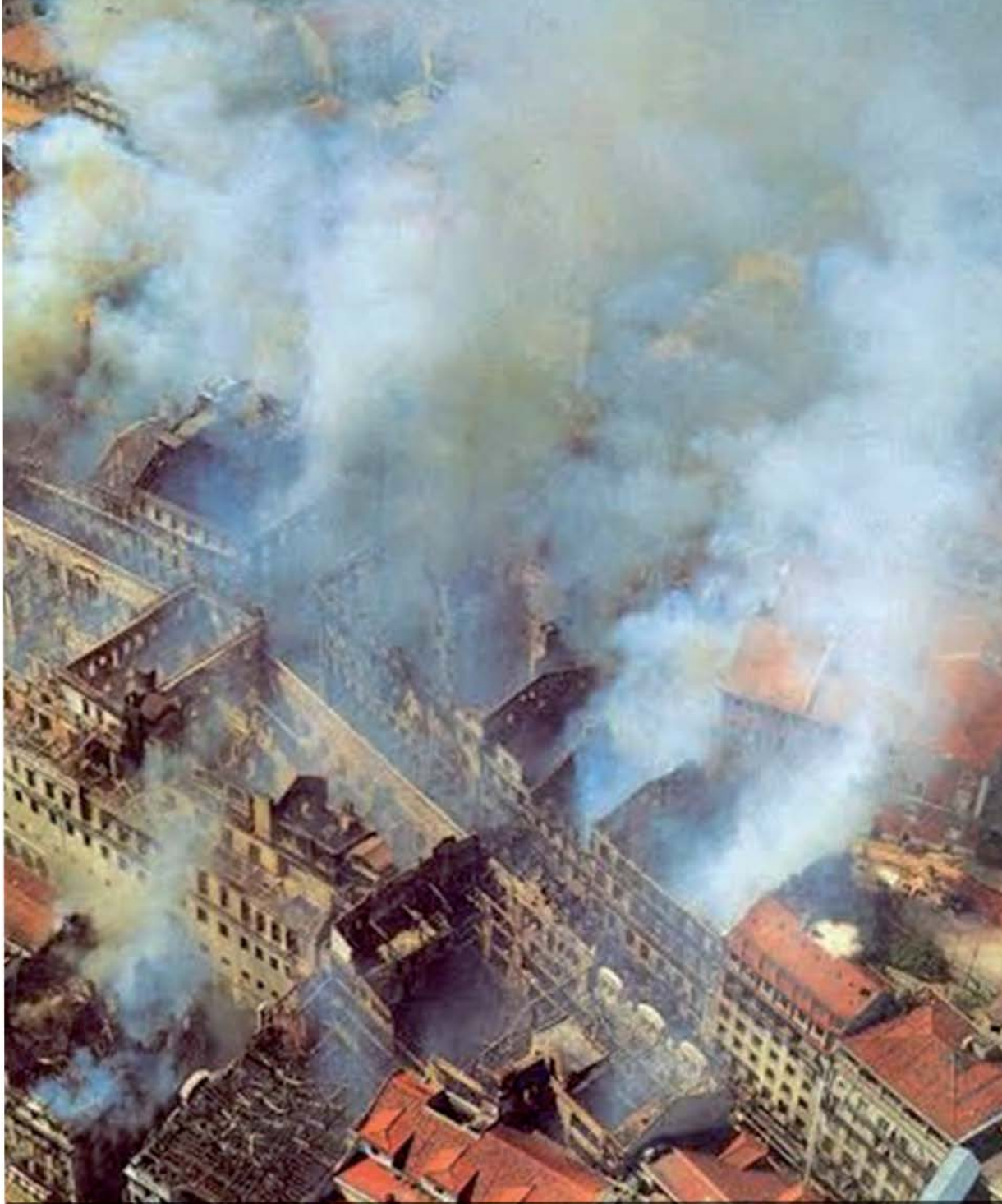
Figura 37 – Perspetiva aérea dos edifícios destruídos pelo incêndio
