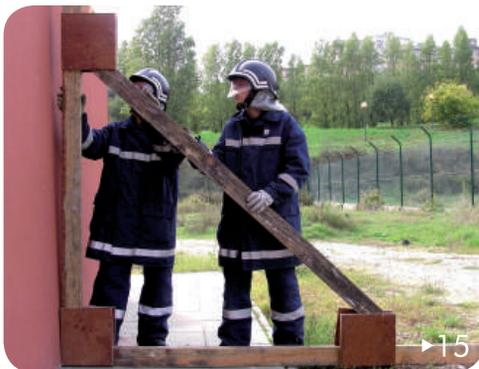
15▶ Encostar um dos cavaletes à parede ou muro a escorar. Retirar
