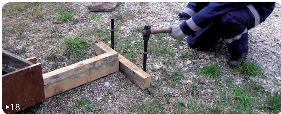
**18** ▶ Colocar um calço (7 x 10 x 60 cm) no extremo da viga-mestra de apoio inferior, e fixá-lo com pelo menos duas estacas metálicas, ou proceder de outro modo, mas de forma a evitar o deslizamento da estrutura no solo.
