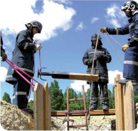
22▶ O resultado da medição deverá ser transmitido aos elementos responsáveis pelos cortes, que prepararão a respetiva escora. Inicialmente, irão efetuar o corte de um barrote 7 x 10 cm, descontando à medida da vala o comprimento do macaco ajustável na posição intermédia da rosca. A peça deverá ser descida para o interior da vala utilizando duas espigas.
