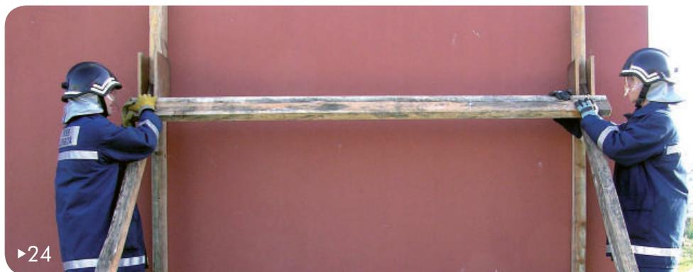
24▶ Colocar e pregar uma prancha na horizontal de modo a apanhar as duas escoras junto às extremidades superiores.
