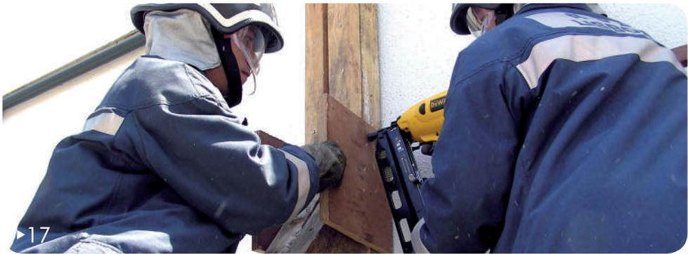
17▶ Unir a escora à viga-mestra de apoio lateral utilizando duas âncoras, uma de cada lado.
