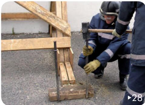
28▶ Para evitar deslizamentos do escoramento, pregar no solo em frente de cada cavalete, no mínimo, duas estacas metálicas.
