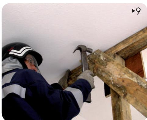
9▶ Seguidamente pregar as âncoras centrais da viga-mestra de apoio superior à escora. Fazer o travamento do escoramento empregando duas tábuas (4 x 10 cm no mínimo) na diagonal uma de cada lado, apanhando as duas vigas-mestra e as três escoras. Começar por pregar a tábua, pre-
