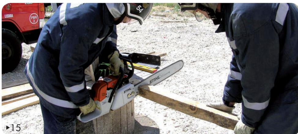
15▶ O resultado da medição deverá ser transmitido aos elementos responsáveis pelos cortes, que prepararão a respetiva escora. Inicialmente, irão efetuar o corte de um barrote de 7 x 10 cm, descontando à medida da vala o comprimento do macaco ajustável na posição intermédia da rosca.
