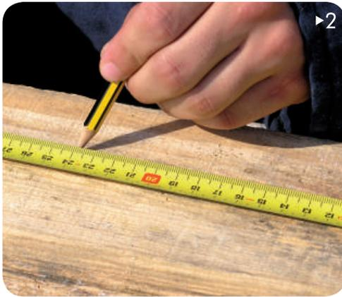
2▶ Dos barrotes, cortar quatro peças, descontando 24 cm à altura do vão para as duas escoras verticais e 4 cm para as duas escoras horizontais.
