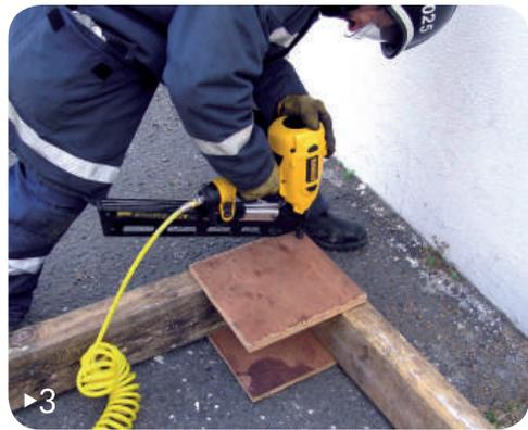
3▶ Unir as duas vigas-mestra utilizando duas âncoras.
