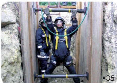
**33▶** Um dos elementos da equipa de entrada efetua uma medição entre os dois painéis, cerca de 60 cm do bordo da vala.
