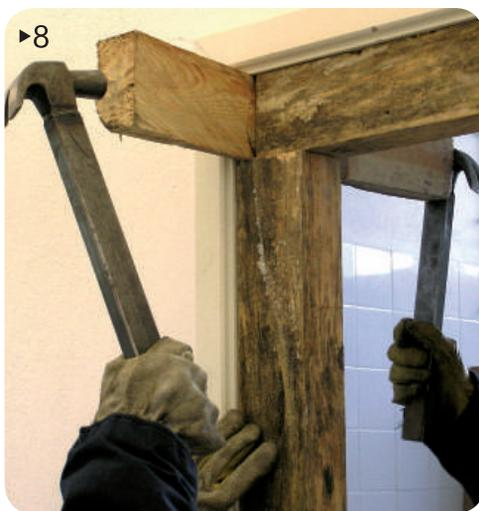
Quando não for possível o ajuste simultâneo das duas cunhas por um só elemento, um ampara a cunha enquanto o outro ajusta.
