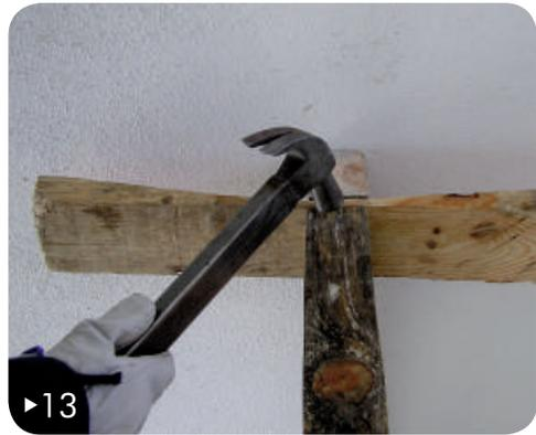
13► Faz o ajuste final utilizando dois martelos em simultâneo. Pregar um prego na escora de modo a apanhar as duas cunhas.
