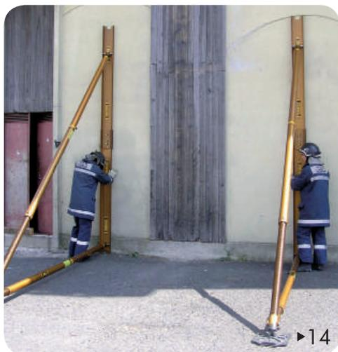
12► Colocar uma sapata na adaptação de união dupla.
