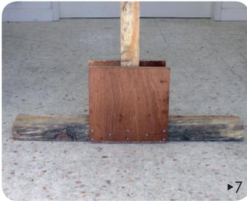
7▶ Colocar a viga-mestra de apoio inferior centrada entre o piso e a escora.
