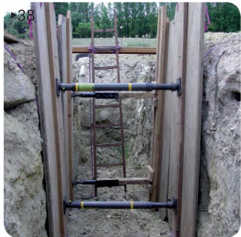
De seguida é retirada a pressão do macaco, e desconectada a mangueira de fornecimento de ar pelo elemento da equipa de entrada.
