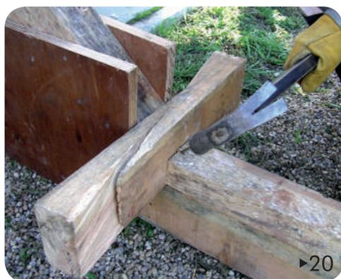
**19** ▶ Colocar manualmente um par de cunhas entre o topo inferior da escora e o calço (5 x 7 x 60 cm). Empregando dois martelos em simultâneo, fazer o ajuste final.
