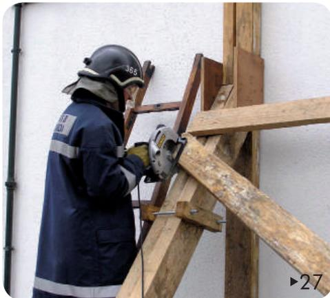
27▶ Cortar as partes salientes das pranchas utilizadas no travamento.
