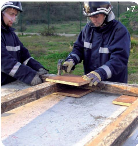
6 ▶ À distância de 30 cm das extremidades de uma viga-mestra colocar duas escoras, uma de cada lado e pregá-las com duas âncoras.
