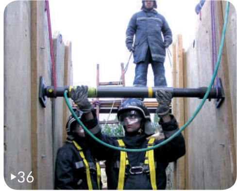
36▶ Um dos elementos situado no exterior da vala irá pressurizar o macaco “Paratech” através do dispositivo de comando, distribuição e regulação, com uma pressão máxima de 7 Bares para que este exerça pressão nos painéis.
