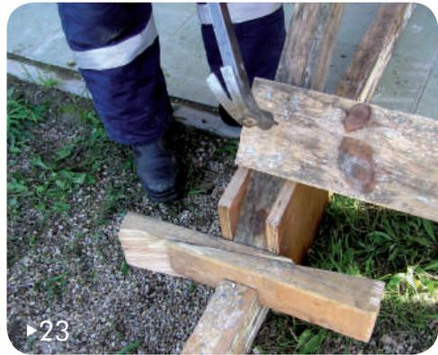
23▶ Colocar e pregar uma prancha na horizontal de modo a apanhar as duas extremidades inferiores das escoras junto às âncoras.
