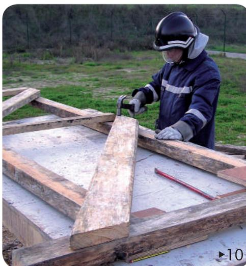
9 ▶ Colocar uma prancha na diagonal de modo a apanhar as duas escoras, marcar, cortar e pregá-la.
