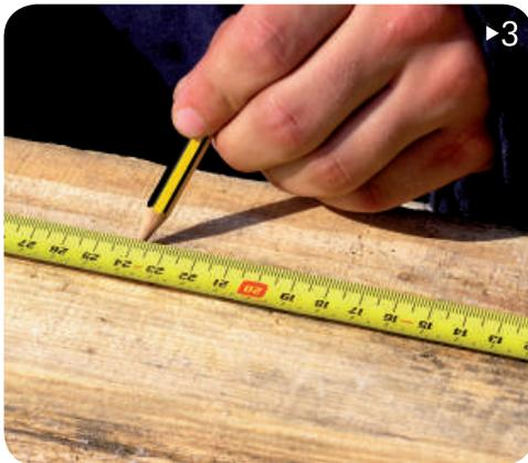
3▶ Dos barrotes, cortar duas escoras verticais, descontando 24 cm à altura do vão, caso se trate de deformação da verga, ou 4 cm se existir deformação das ombreiras.
