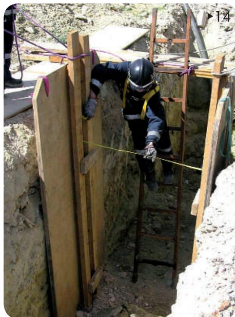
Para segurança da equipa de entrada, o escoramento dos dois primeiros painéis deverá começar pela colocação de uma escora a nível superior (borda da vala), seguindo-se a colocação da segunda ao nível inferior (fundo da vala), mas se o espaço entre escoras for superior a 1,20 m opta-se por colocar três escoras. No escoramento dos painéis seguintes a ordem de colocação das escoras deverá ser efetuada pela ordem inversa.
