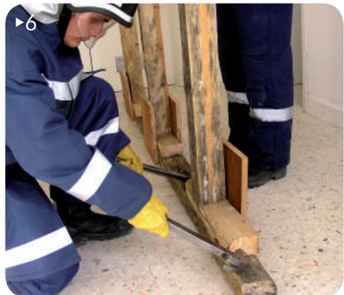
7▶ Seguidamente verifica a verticalidade do escoramento. Fixar cada cunha à viga-mestra de apoio inferior com um prego.
