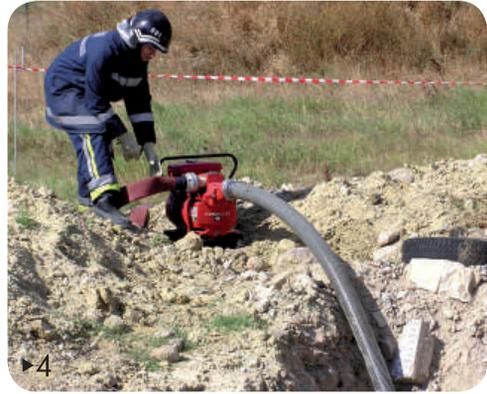
4 ▶ Proceder de modo a minimizar os perigos decorrentes da rotura de canalizações de água, gás, eletricidade ou outros. Se necessário proceder à ventilação. Se houver a presença de água efetuar a sua aspiração.
