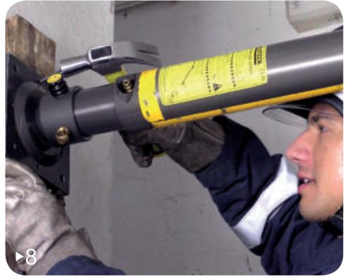
8 ▶ Ajustar manualmente o macaco, fixando com pregos as bases nas vigas-mestra de apoio lateral.
