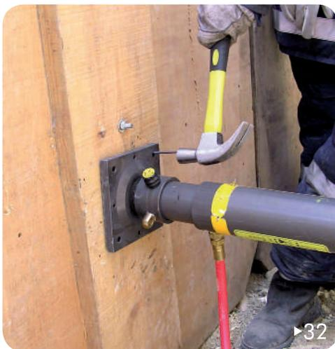
32▶ O elemento situado no interior da vala faz o ajuste manual da rosca do macaco e prega as bases da escora “Paratech” aos painéis.
