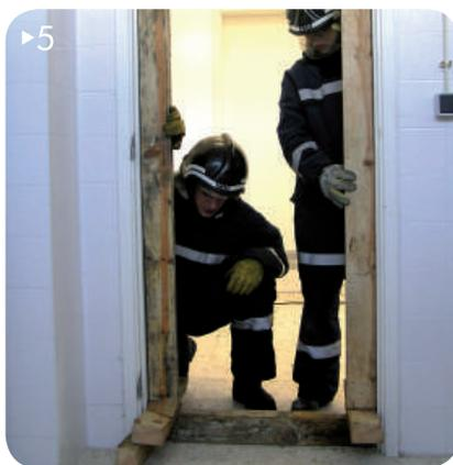
6▶ Colocar a escora horizontal superior em cutelo sobre as escoras verticais encostando-a para um dos lados.
