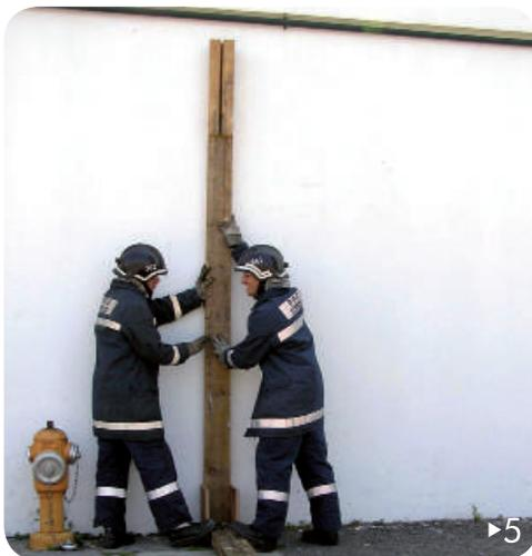
4▶ Cortar dois calços 5 x 7 x 60 cm e pregá-los coincidentes com o topo de uma das vigas-mestra.
