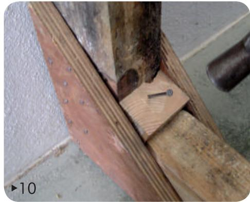
10▶ Ajustar a cunha utilizando um martelo. Fixá-las com um prego à viga-mestra.
