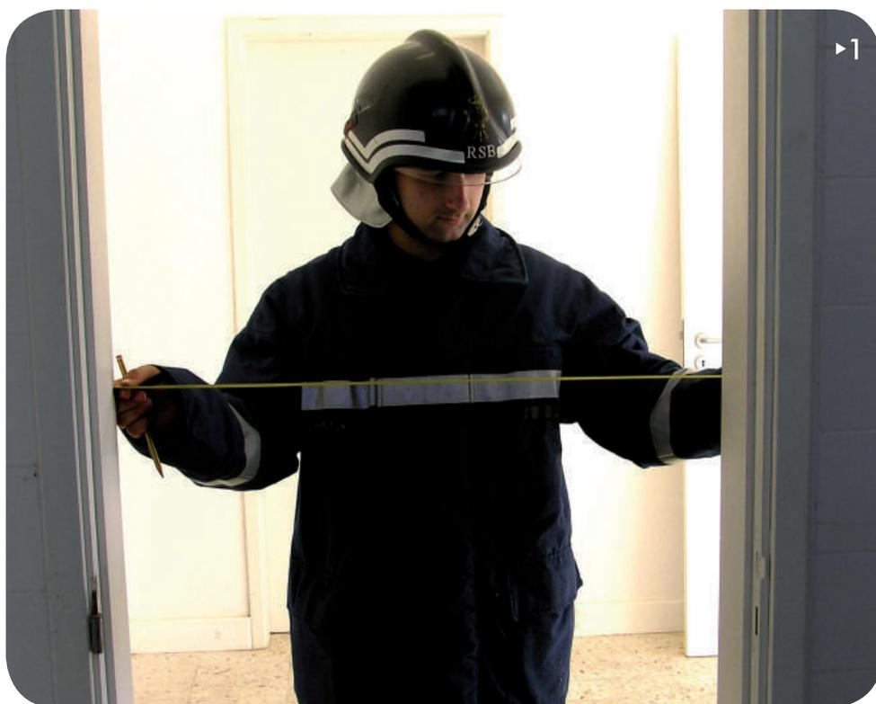
2▶ Dos barrotes, cortar duas escoras horizontais, descontando 4 cm à largura do vão, caso exista deformação da verga, ou 24 cm se a deformação for nas ombreiras.
