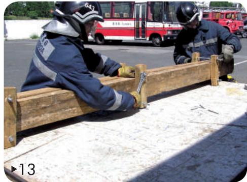
12▶ Fazer três abraçadeiras utilizando o seguinte material: 6 bocados de barrote de 5 x 7 x 25 cm, que deverá ser furado próximo dos topos, varão roscado com cerca de 25 cm e porcas.
