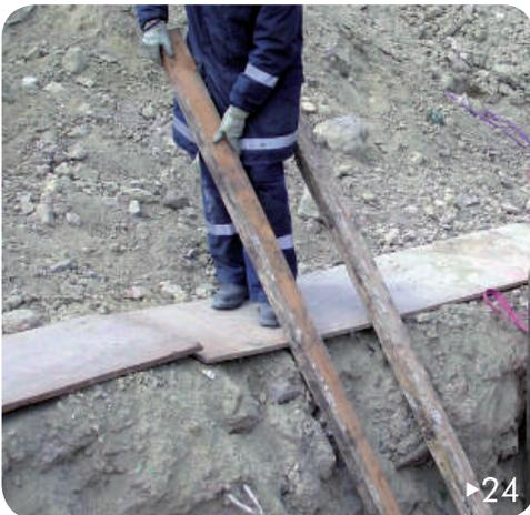
23▶ Colocar a escora no local onde foi efetuada a medição. Ajustar a escora manualmente através do macaco extensível e pregá-la ao painel. Do lado oposto, travar o movimento vertical da escora utilizando para o efeito uma pequena peça de madeira.
