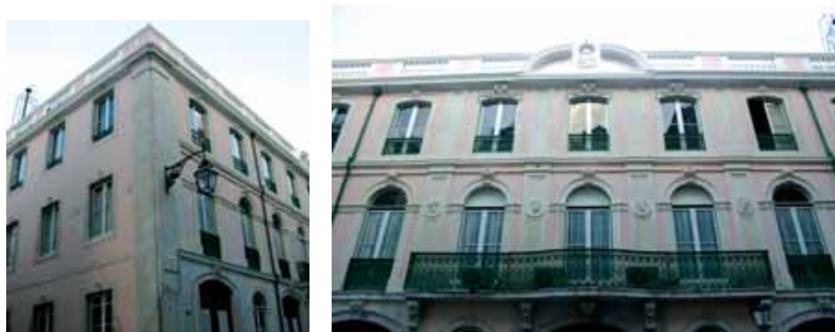
Fig. 4 – Edifício do Grémio Literário, Rua Ivens, 37, após a realização de obras.
