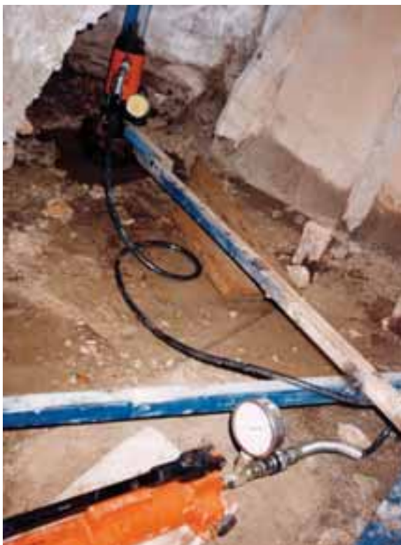
Fig. 8 – Ensaio de carga de uma estaca curta de madeira. Sistemas de carga e de leitura.
