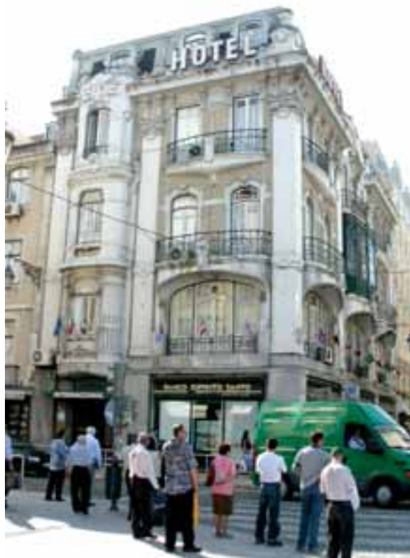
Fig. 7 – Rua da Betesga, 3 – Hotel Internacional.
