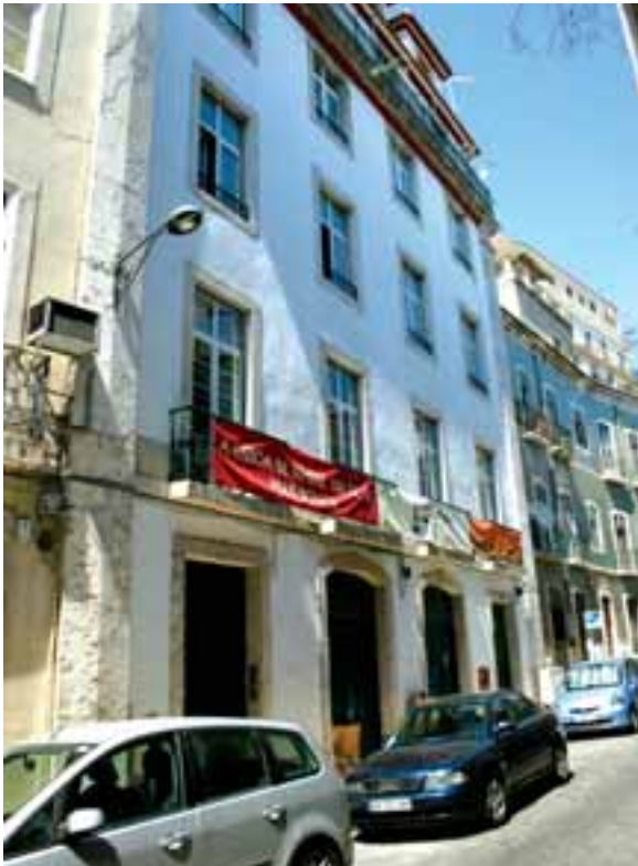
Fig. 6 – Edifício reabilitado, na Rua do Ferragial, 32 a 34.
