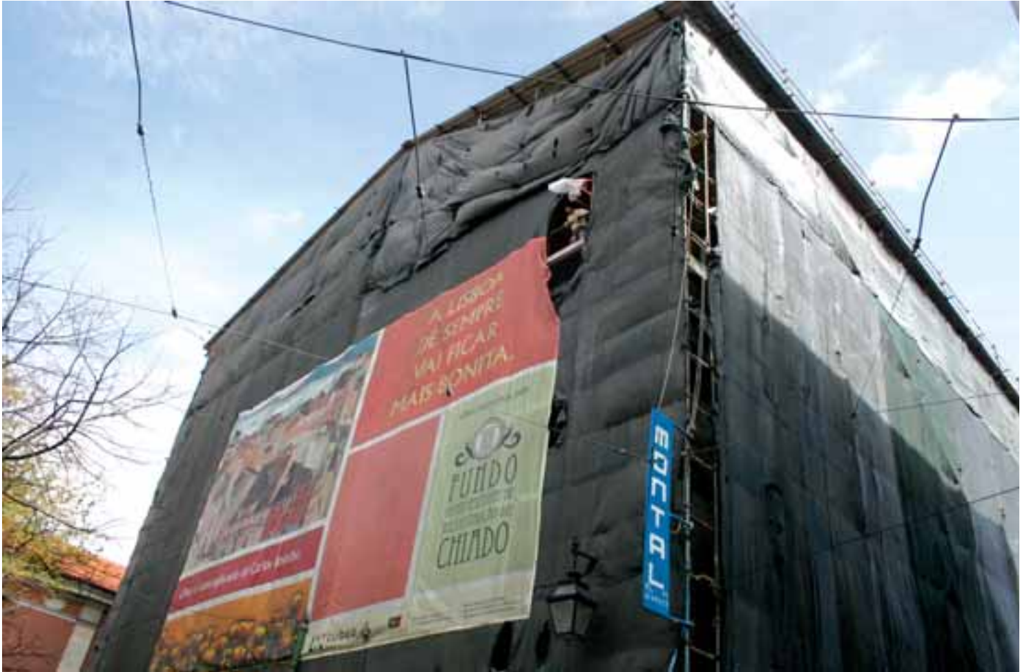
Fig. 5 – Obras de reabilitação do edifício 1 a 7, no Largo do Carmo.
