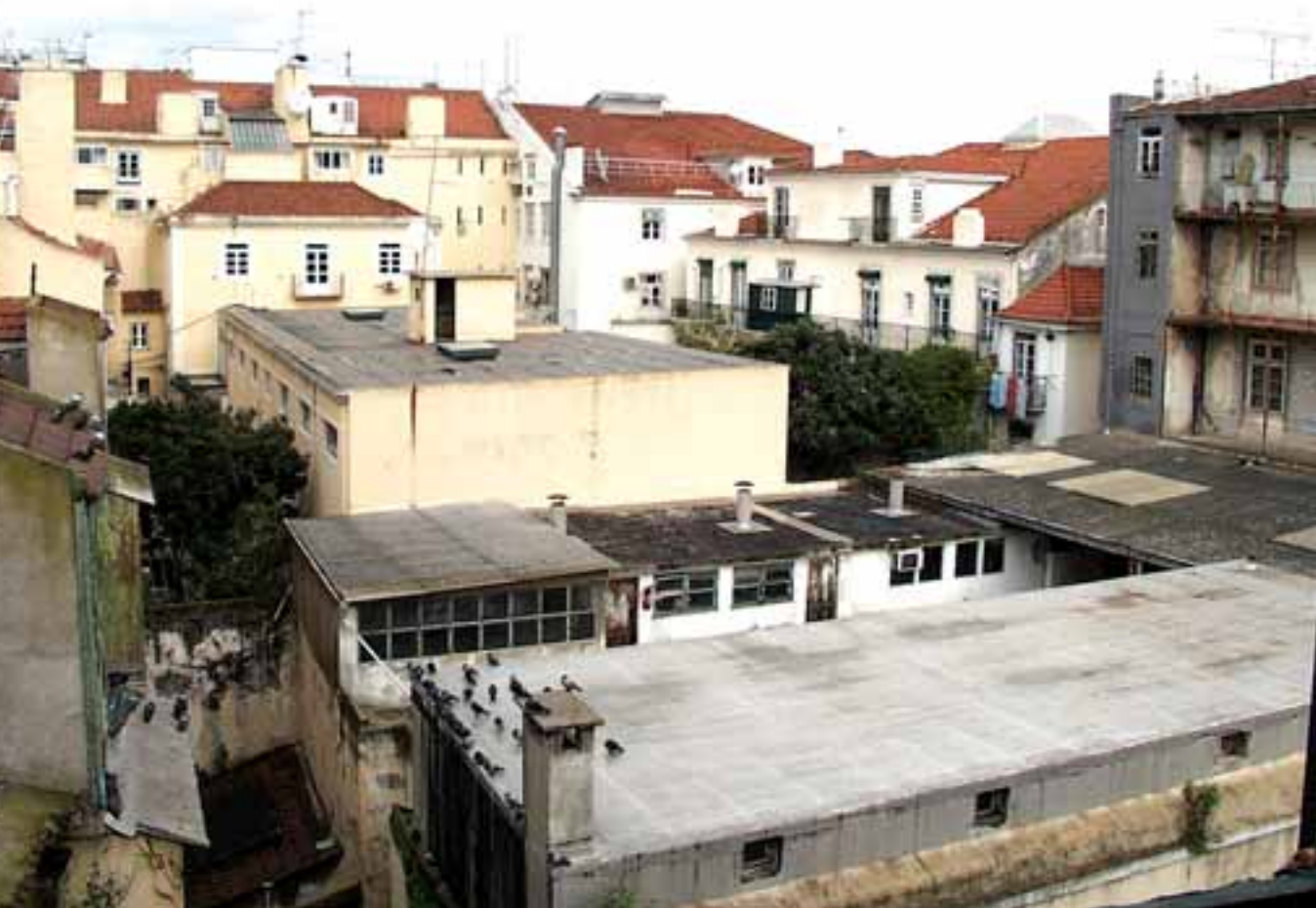
Fig.11 – Interior de quarteirão (Rua Ivens, Rua Capelo, Rua Anchieta e Rua Garrett).
