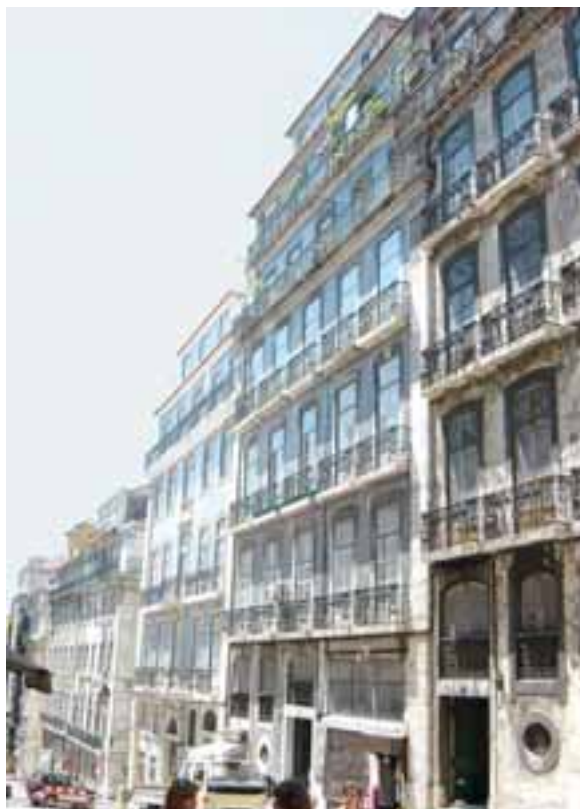
Fig. 13 – Rua da Madalena, 89-93. Exemplo de edifício com dois pisos de varanda corrida e trapeirão.
