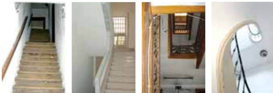
Fig. 14 – Exemplos de escada de tiro (Rua da Conceição 51-61/Rua da Praia 52-66); escada pombalina (Praça da Figueira, 12-12D); escada neoclássica (Rua da Madalena, 102-108/Rua das Pedras Negras, 34-38); e escada gaioleira (Rua da Madalena, 146A-156).
