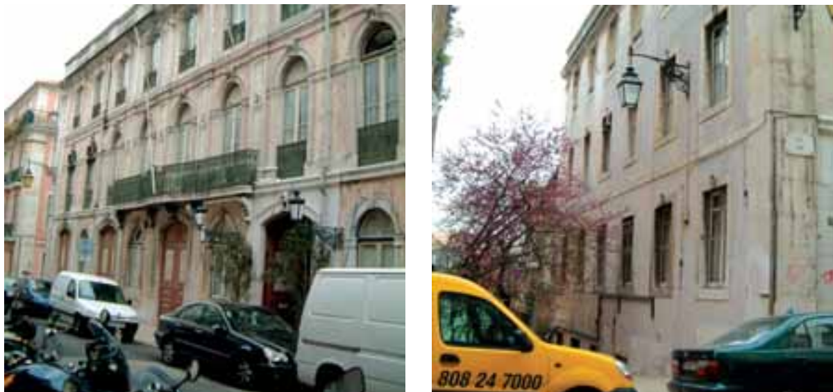
Fig. 1 e 2 – Grémio Literário, Rua Ivens, 37, antes das obras de reabilitação.
