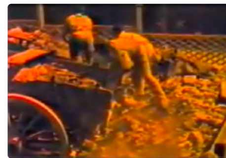
Fig 6 Processos de preparação do barro. Da esquerda para a direita: Receção do barro, decantação das impurezas e secagem. Pormenores (captura de ecrã) de documentário sobre a produção de azulejo na Fábrica de Cerâmica Constância da autoria de A.C. Macedo (1921-1936). 22
