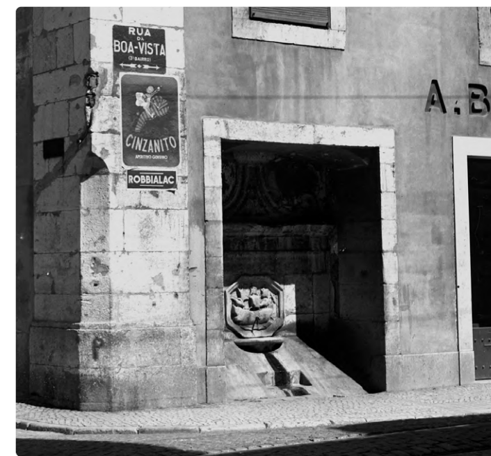
Fig 4 Bica dos Olhos , actual freguesia da Misericórdia. Rua da Boavista nº 32 esquina com a Travessa do Marquês de Sampaio nº2. Negativo de gelatina e prata em vidro de Eduardo Portugal, 1951. AML: PT/AMLSB/CMLSB/AH/PCSP/04/EDP/000385
