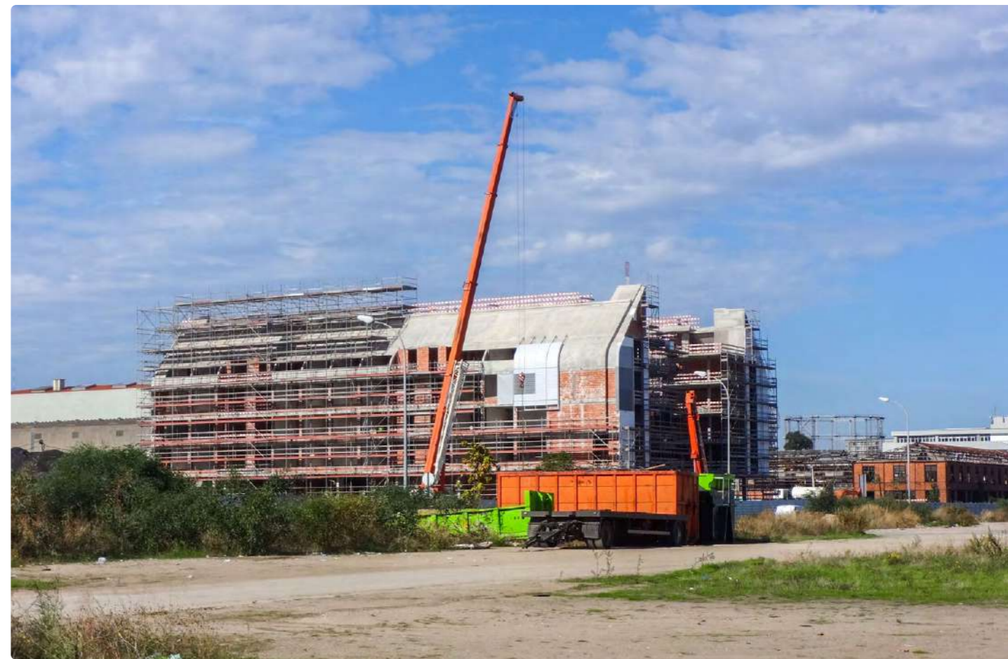
Fig 7 Vista da construção do empreendimento habitacional “Jardins Braço de Prata” (2ª Fase), em Braço de Prata. Ana Nevado. 2016.
