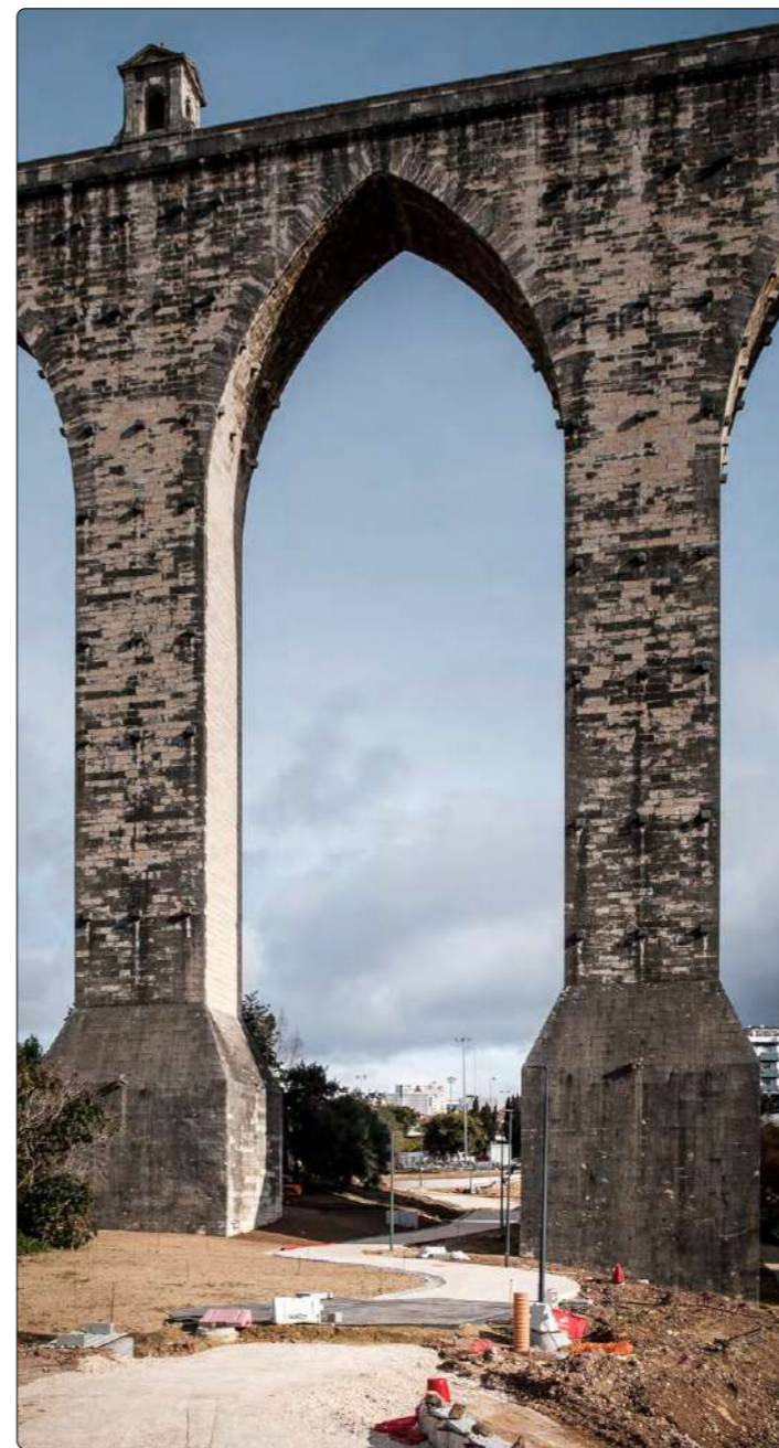
Aqueduto, Corredor Estruturante / Vale de Alcantara - José Vicente, 2019
