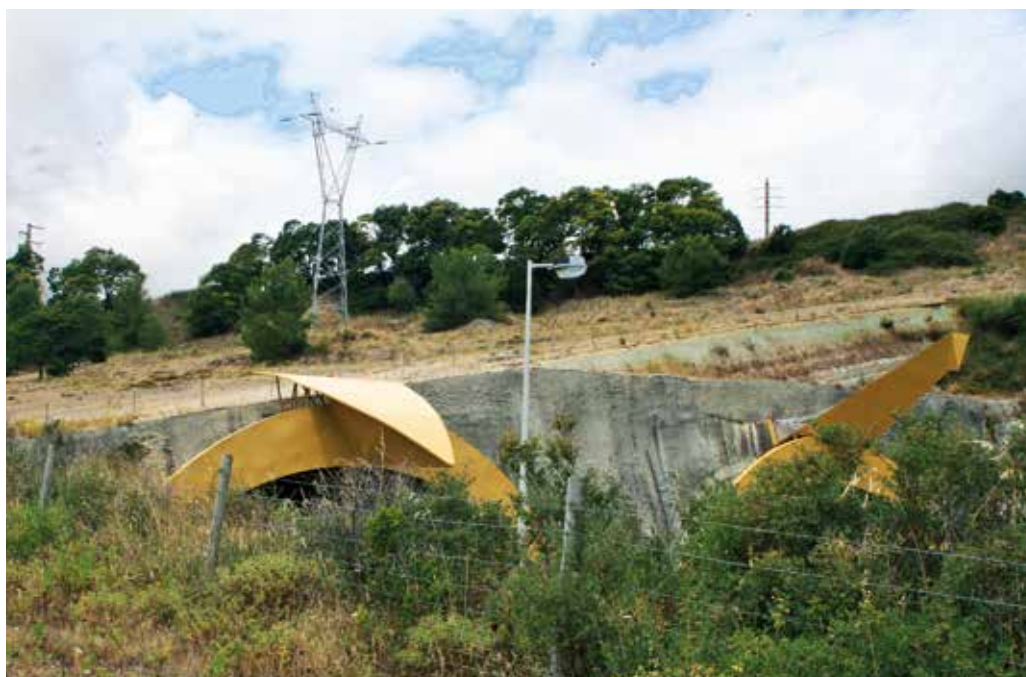
Os túneis e o local das pegadas de dinossáurios (Carenque).
