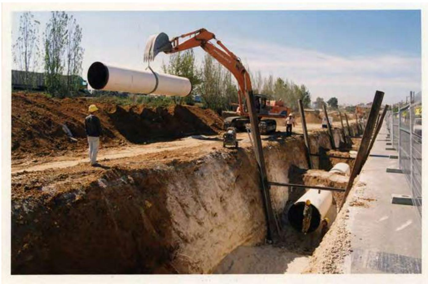
**Figura 23** Obras de renovação de condutas de ferro fundido e fibrocimento por polietileno de alta densidade. Assentamento de canalização do adutor Vila Franca de Xira – Telheiras. EPAL, PT/EPAL\_CDHT/AH/AF-EPAL/EPAL27/2002\_0150
