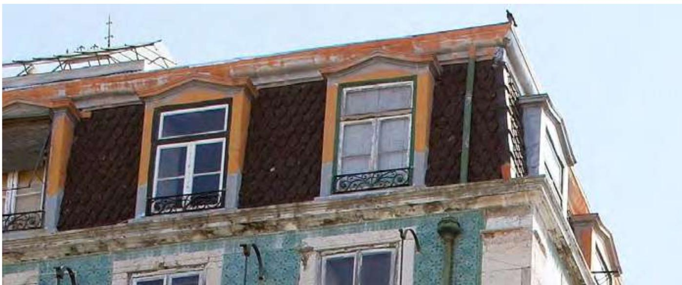
**Figura 8** Mansarda com revestimento de soletos de ardósia, adicionada em 1886 em edifício de gaveto na Rua da Vitória, 10 a 16, com a Rua dos Douradores, 96 a 104 (AML, Obra n.º 9997). Fotografia de Concierge. 2C, 2009, Wikipedia.
