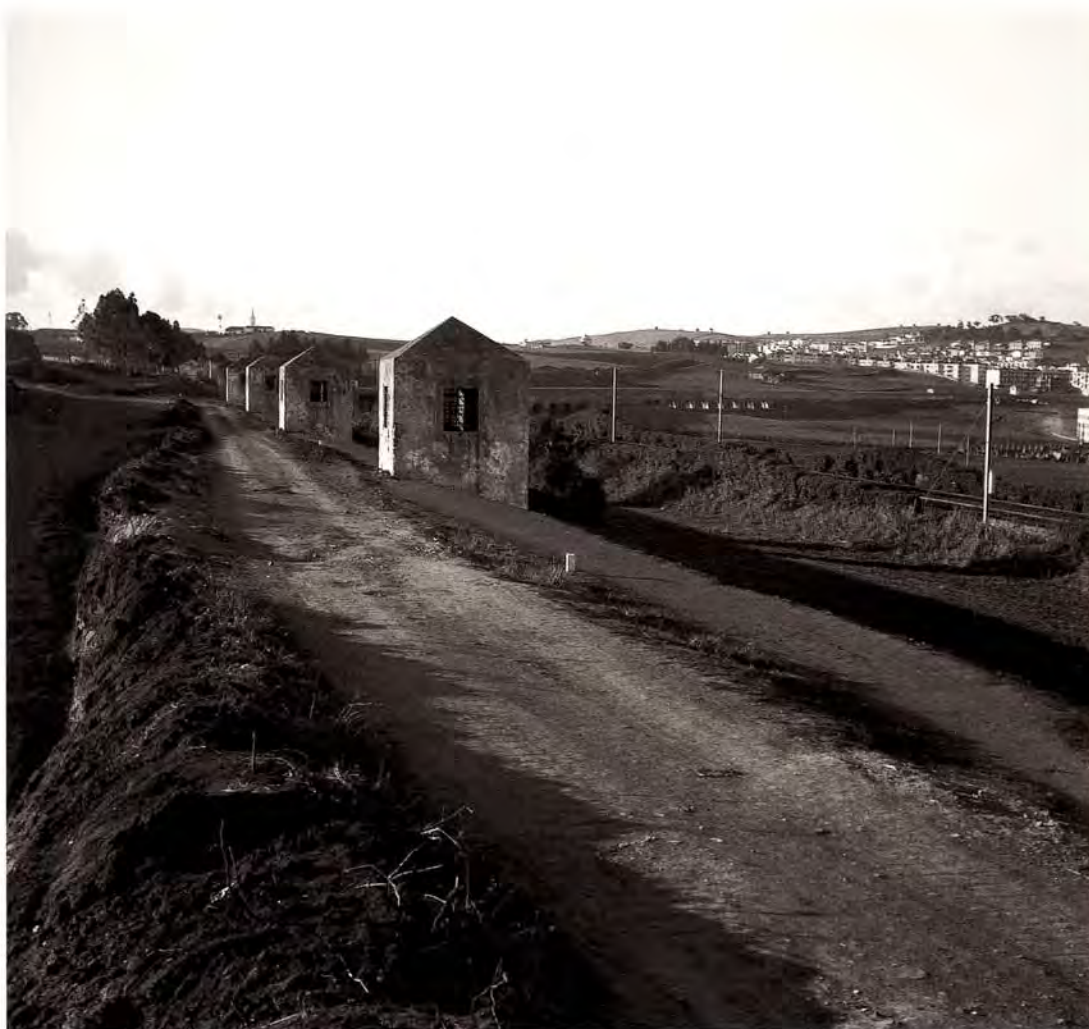
3. Clarabóias do Aqueduto das Águas Livres na Damaia. Sky-lights of the Aqueduct of Águas Livres in Damaia.
