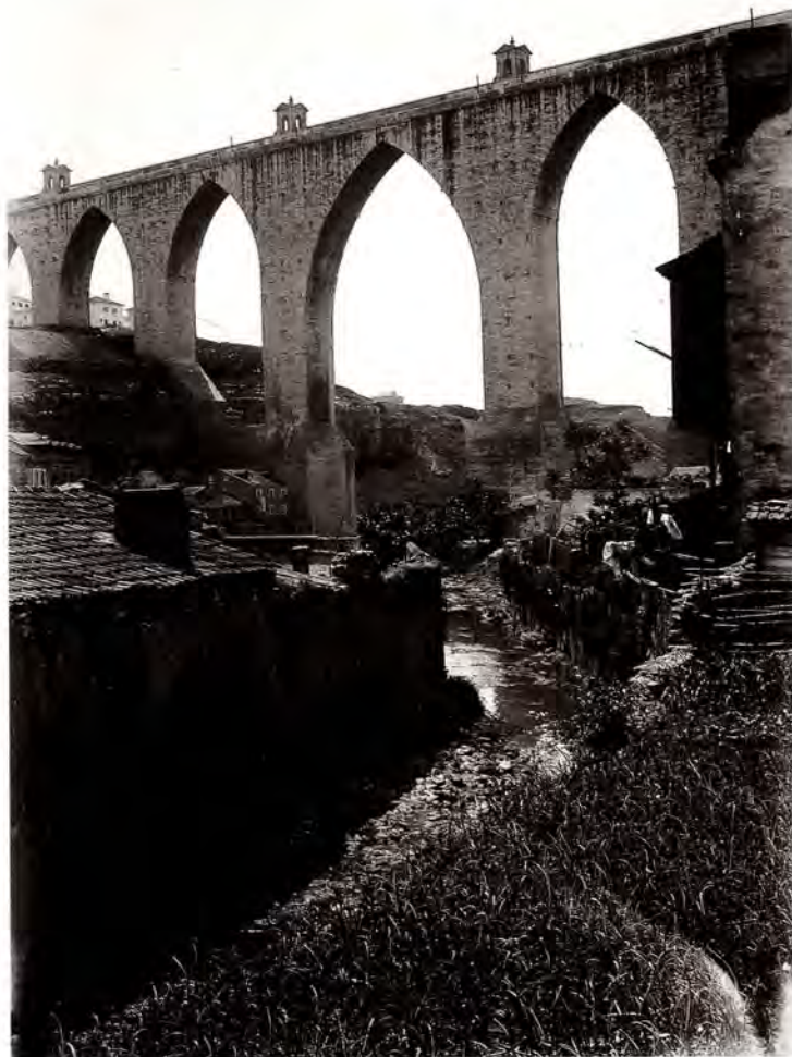
27. Ribeira de Alcântara sob o Aqueduto das Águas Livres. Alcântara's Riverside beneath the Aqueduct of Águas Livres.
