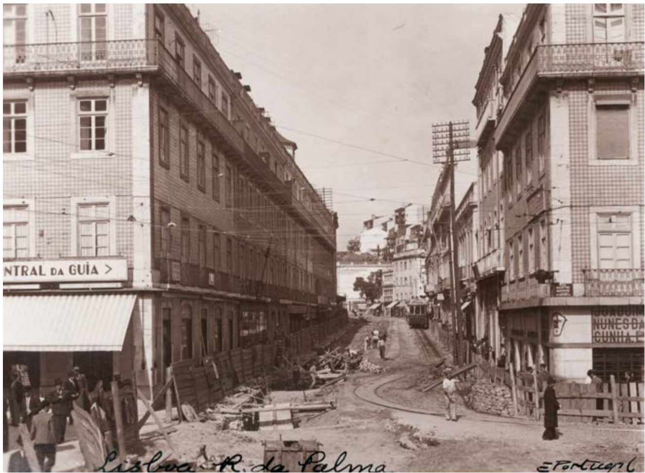
Rua da Palma, construção do coletor, cruzamento com a rua Martim Moniz, antes das demolições. s.d. PT/AMLSB/POR/058970
