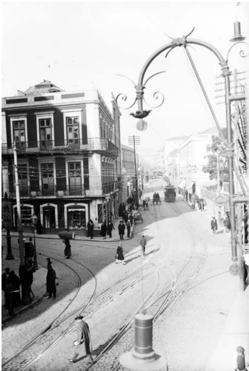
Panorâmica tirada do Teatro Apolo sobre a rua da Palma no cruzamento da rua de São Lázaro, antes das demolições. 1927. PT/AMLSB/POR/014987
