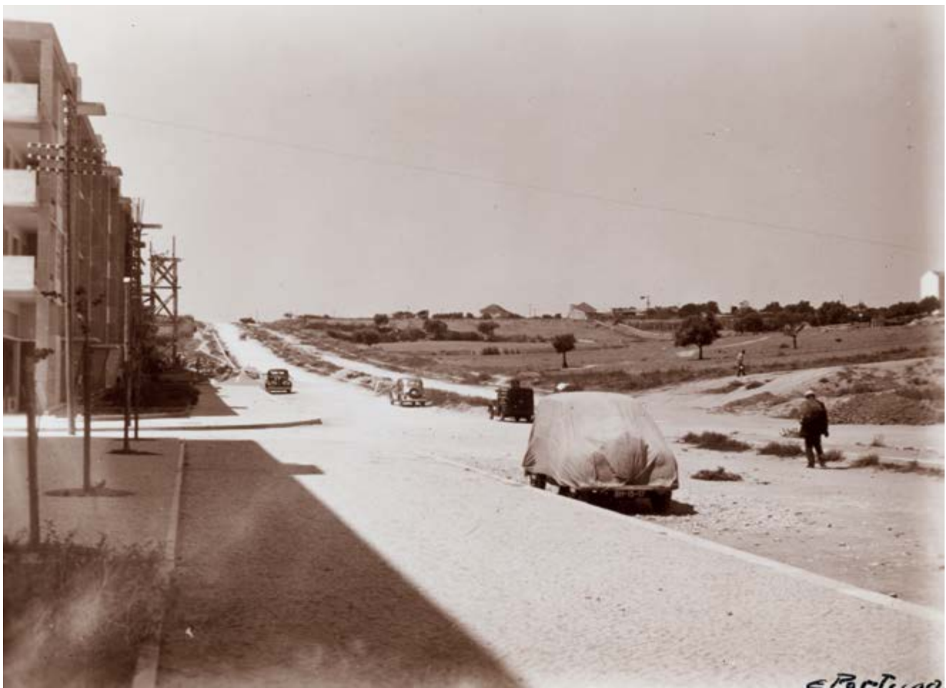
Abertura da avenida dos Estados Unidos da América. 1951. PT/AMLSB/EDP/000344
