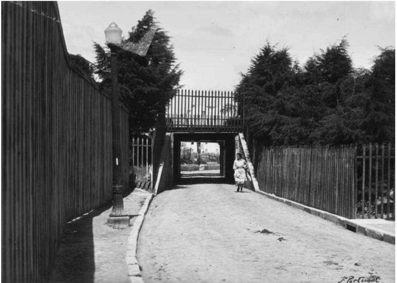
Viaduto de Entrecampos sobre a avenida 5 de Outubro. 1944. PT/AMLSB/EDP/001290
