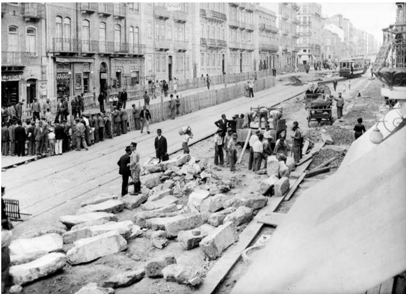
Obras na avenida Almirante Reis. Quarteirão entre a rua dos Anjos e a rua Antero de Quental. 1939. PT/AMLSB/POR/015717
