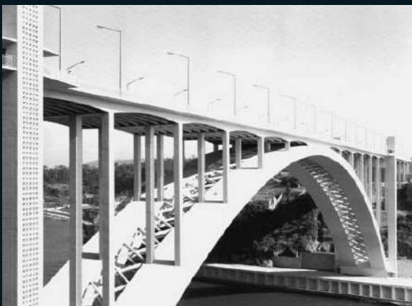
Ponte rodoviária da Arrábida
