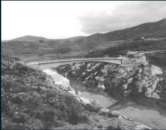
Ponte de S. Fins
