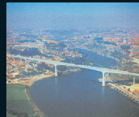
Ponte ferroviária S. João
