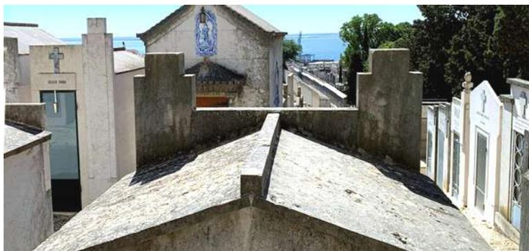
Telhado de duas águas ocultado por platibanda (tardoz)
