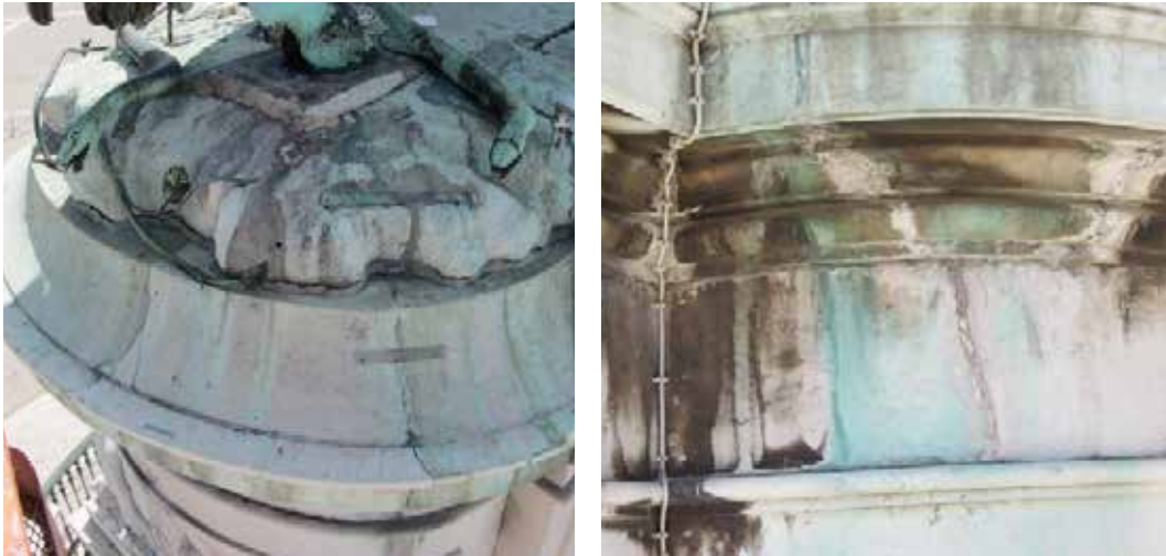
Fig. 4 - Pormenor da parte superior do pedestal onde se observam diversas fracturas. Notem-se os grampos para estabilização de fracturas aplicados em intervenções anteriores.
