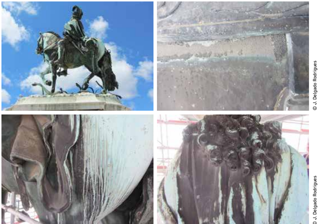
Fig. 1 - Aspecto do conjunto escultórico fortemente marcado pelo contraste de cores deixadas pela sujidade e pelos produtos de alteração da liga metálica.
