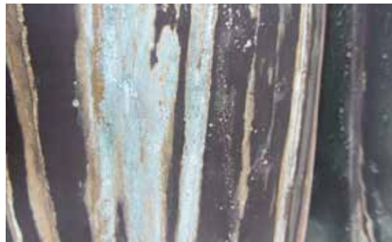
Fig. 6 – Formação de linhas de pátina verde em zonas de pátina preta, nas linhas de escoamento de água.
