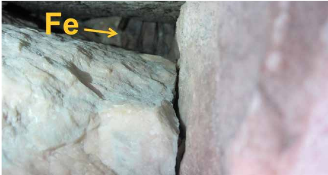
Fig. 7 - Vista para o interior do pedestal em zona onde havia lacuna por destacamento de um fragmento do bloco de pedra. No fundo vê-se um espigão de ferro, que também foi identificado pelo georradar. Notem-se ainda as fracturas dos blocos em estreita ligação com o espigão oxidado.
