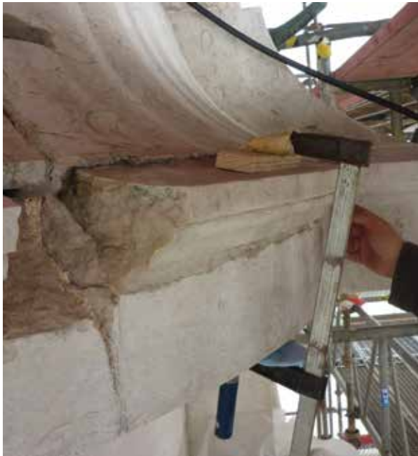
Figs.14-15 – Estabilização e colagem de fragmentos de grande porte no topo Norte. Injeção em profundidade em fracturas e juntas de zonas fragilizadas do plinto.
