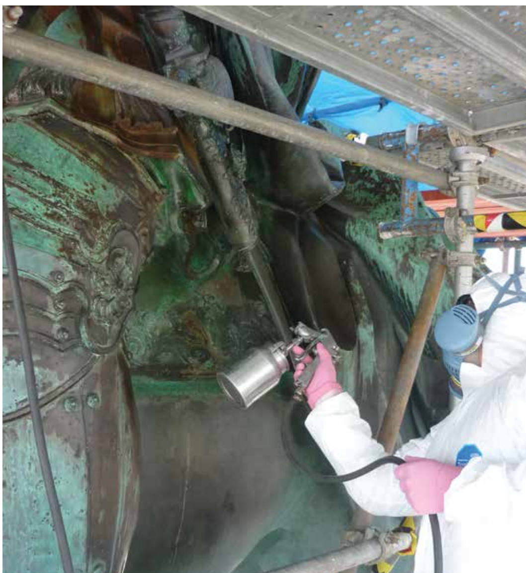
Fig.26 – Aplicação de protecção final por aspersão sobre as superfícies lisas.
