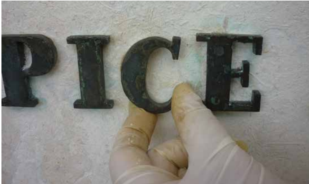
Fig.21 – Recolocação de caractere solto.
