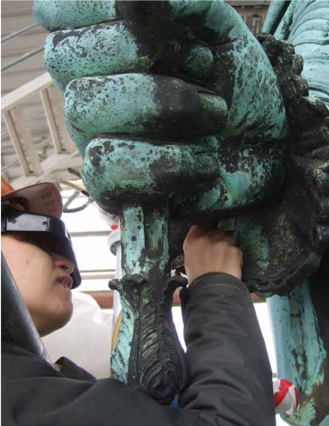
Fig.2 – Limpeza mecânica de incrustações espessas.
