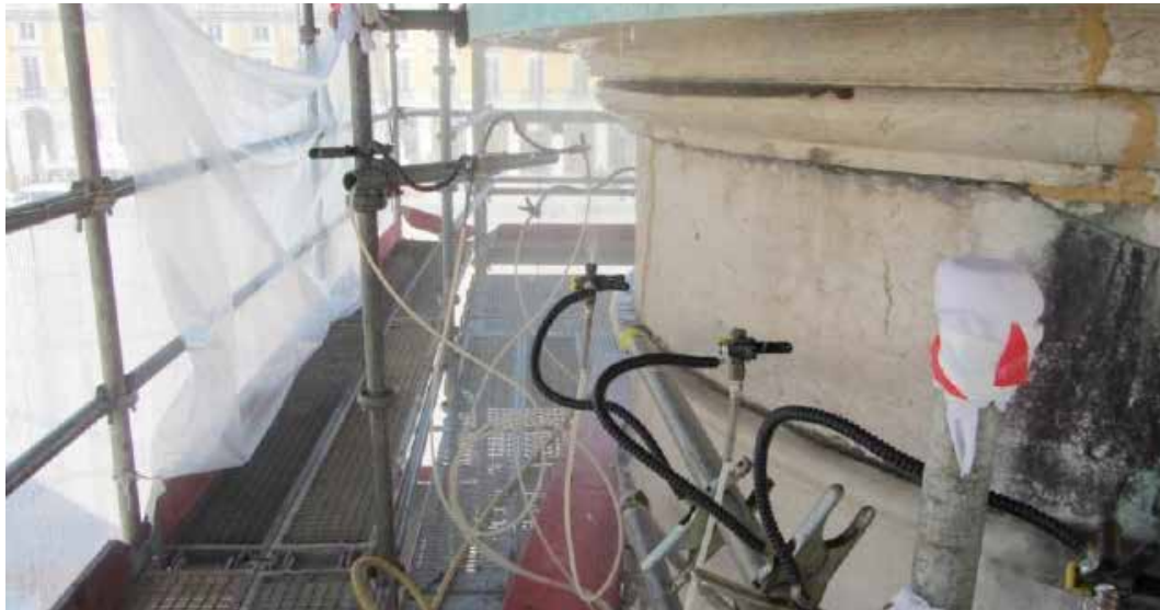
Fig. 9 - Aspecto do estaleiro de obra durante as operações de nebulização.
