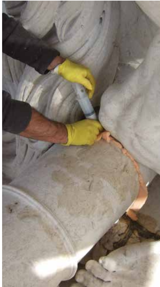
Fig.10 – Preenchimento em elemento escultórico com argamassa fluida de desempenho estrutural.
