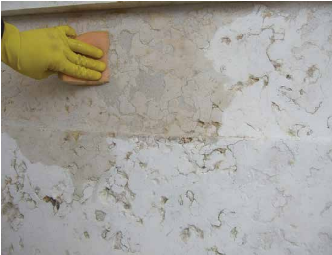
Figs.11-13 – Refechamento superficial de juntas e de pequenas discontinuidades no substrato pétreo.
