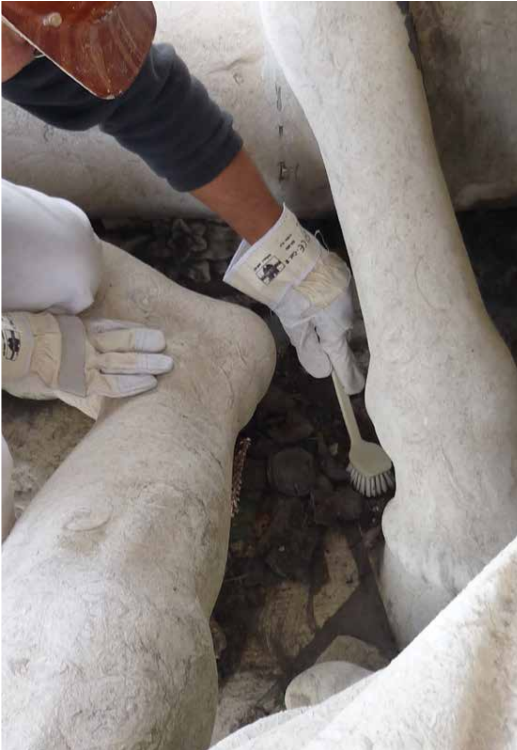
Fig.1 - Limpeza mecânica dos depósitos soltos de porte mais significativo.
