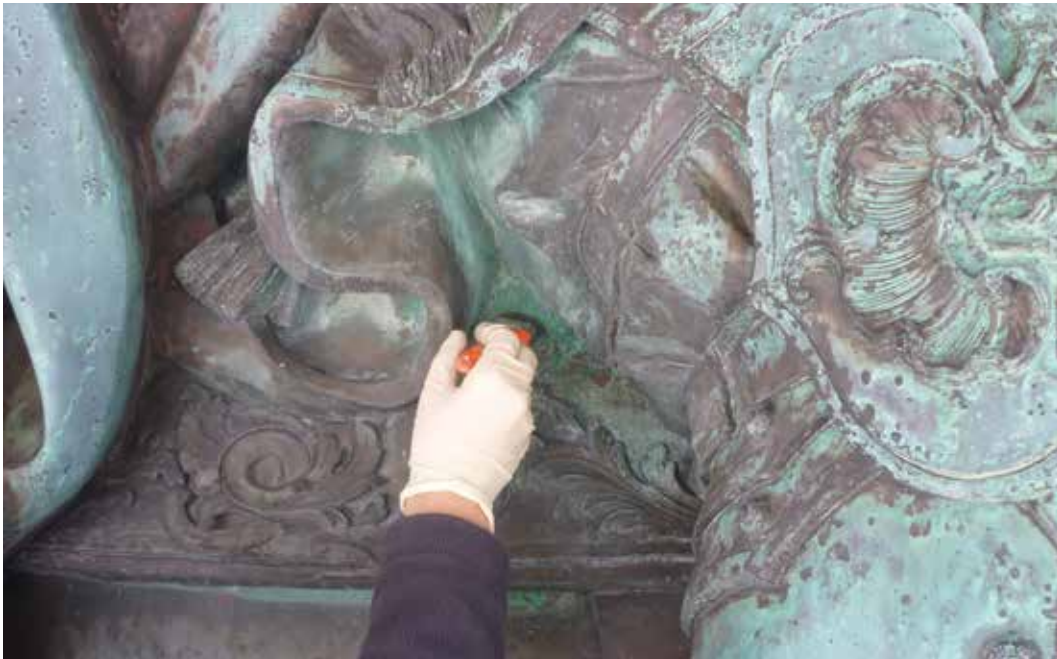
Fig.13 – Passivação preventiva da liga metálica com água de cal.
