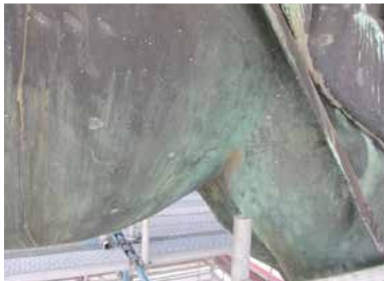
Fig. 8 – Zona de pátina preta com uma subcamada de pátina verde.
