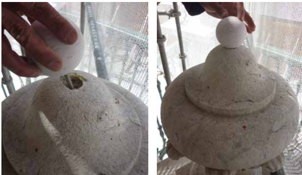
Figs.21 e 22 – Recolocação de uma das réplicas dos elementos esféricos de remate das urnas decorativas (pilaretes do muro periférico).
