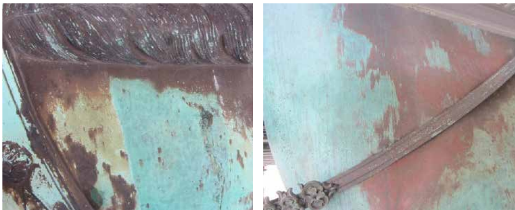
Fig. 5 – Aspecto da situação antes da limpeza (esquerda) com janela de teste e uma situação na condição final após concluída a limpeza (direita). A presença de camada de cuprite avermelhada é contínua nas áreas anteriormente negras, enquanto que a coloração avermelhada é apenas perceptível por transparência através dos depósitos esverdeados.
