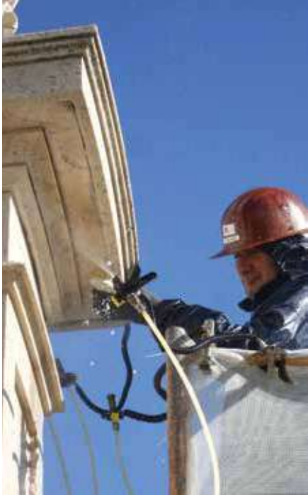
Figs.4 e 5 – Limpeza por via húmida, com sistemas de nebulização e ações de escovagem.
