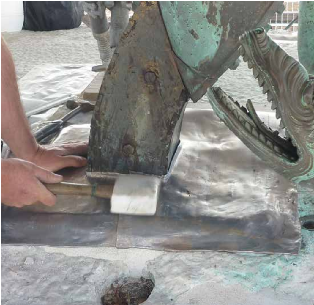
Fig.27 – Criação de revestimento adicional nas sapatas de chumbo da estátua, com pendentes, para desvio das águas pluviais.
