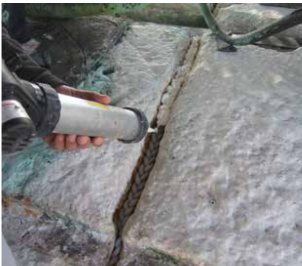
Figs.16 e 17 – Selagem das juntas do topo do plinto com sistema multicamadas.
