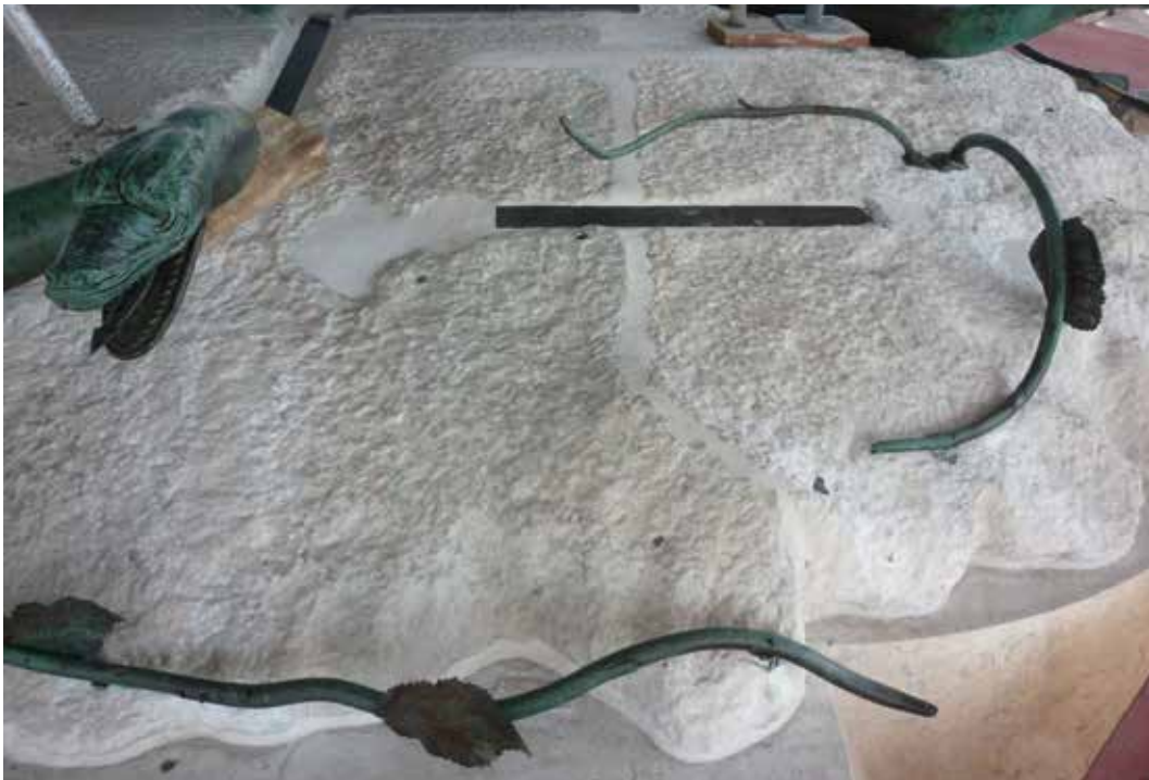
Figs.18-20 - Tratamento de elementos metálicos em ferro do plinto e do topo do pedestal. Revestimento final dos elementos metálicos selados, com argamassas hidráulicas.
