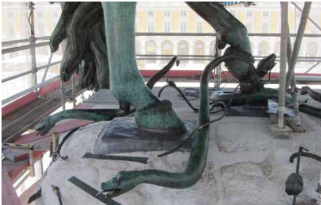
Fig. 8 - Aspecto do capeamento do pedestal após intervenção. Note-se o preenchimento das fracturas e juntas entre blocos e também o novo capeamento com folha de chumbo dos apoios da estátua equestre.
