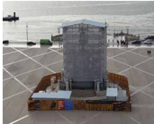
Figs. 13-14 – Montagem de andaimes e vista geral do estaleiro da intervenção.
