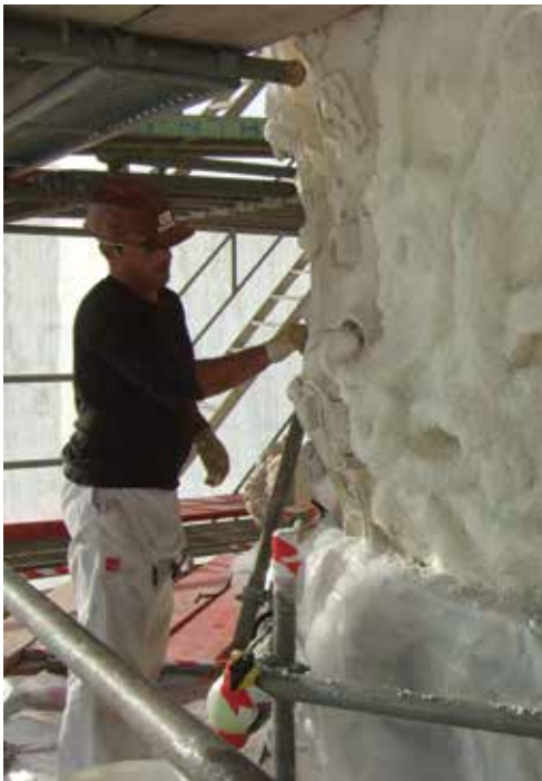
Figs.6 e 7 – Limpeza química das manchas verdes no plinto e nos elementos decorativos do pedestal.
