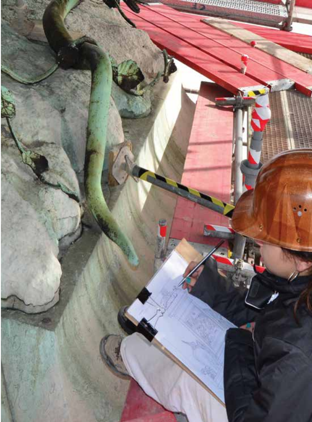
Fig.16 - Mapeamento das formas de alteração e degradação detectadas nos materiais pétreos e argamassas do plinto.
