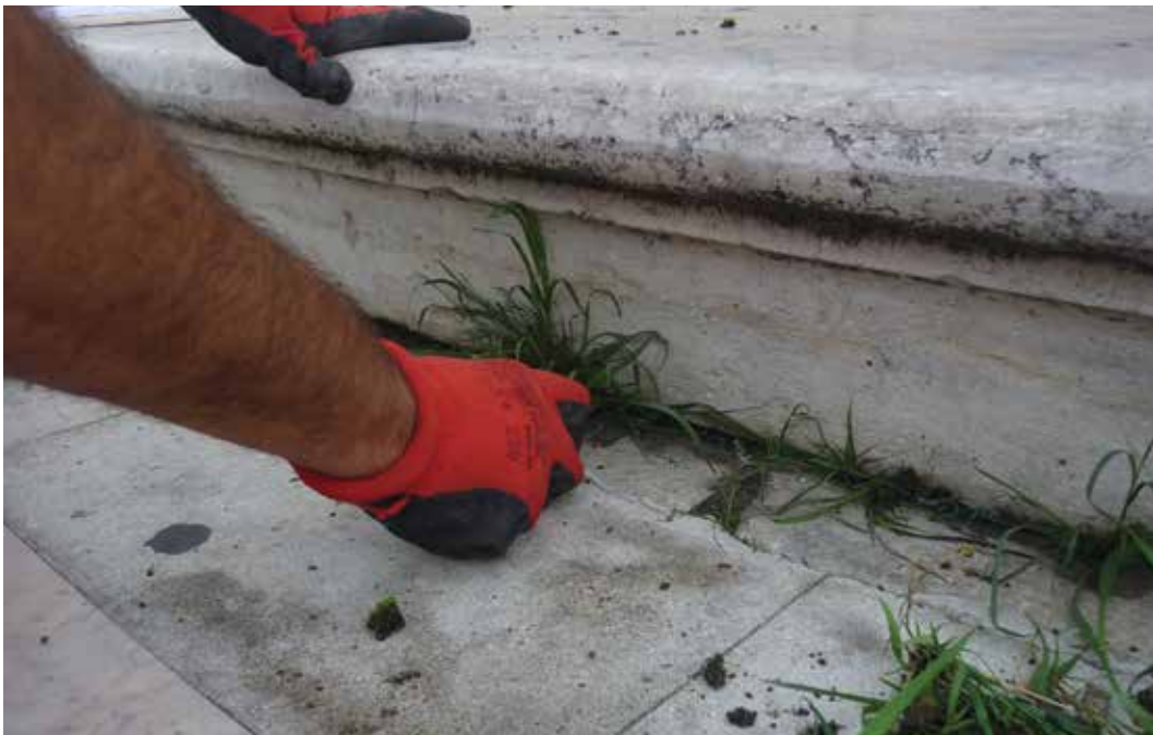
Fig.3 - Limpeza mecânica de vegetação, após aplicação de solução herbicida.
