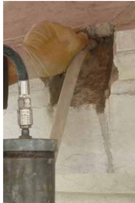
Figs.14-15 – Estabilização e colagem de fragmentos de grande porte no topo Norte. Injeção em profundidade em fracturas e juntas de zonas fragilizadas do plinto.
