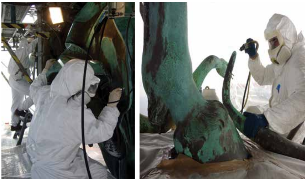
Figs. 3 e 4 – Limpeza das pátinas não coesas e não idóneas por micro-abrasão.
