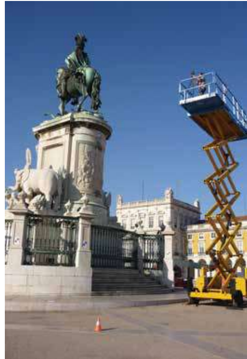
Figs. 1 e 2 – Vistas parciais do monumento a D. José I, durante os trabalhos de levantamento arquitectónico e fotográfico precedente aos trabalhos de conservação e restauro, com auxílio de plataformas elevatórias.
