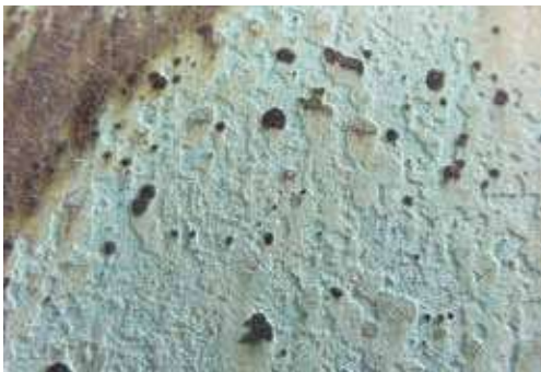
Fig. 5 – Pormenor da pátina verde numa superfície vertical, exibindo zonas de desagregação.
