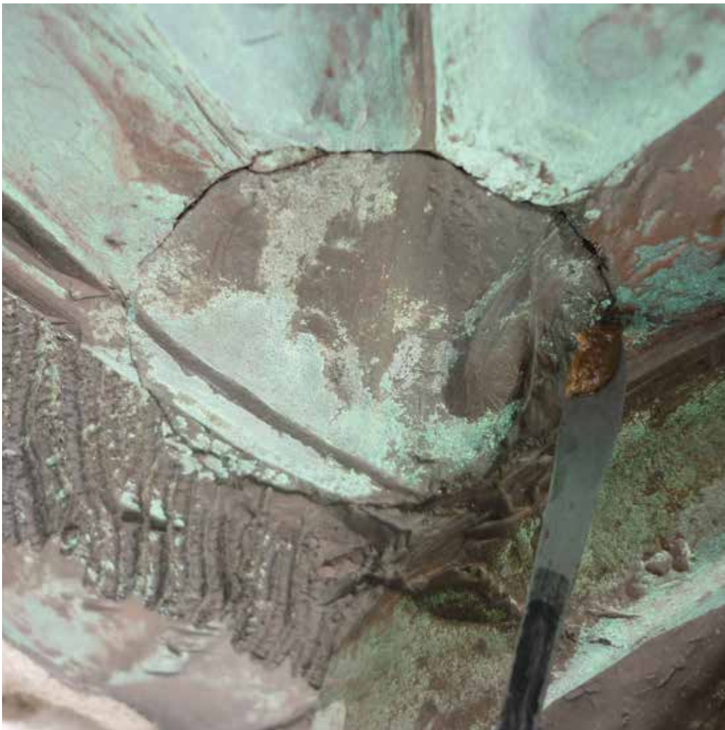
Fig.15 – Preenchimento de descontinuidades com resinas pigmentadas para minimizar entrada de águas pluviais para o interior da estátua equestre.
