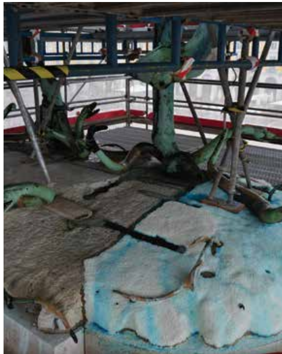
Figs.6 e 7 – Limpeza química das manchas verdes no plinto e nos elementos decorativos do pedestal.
