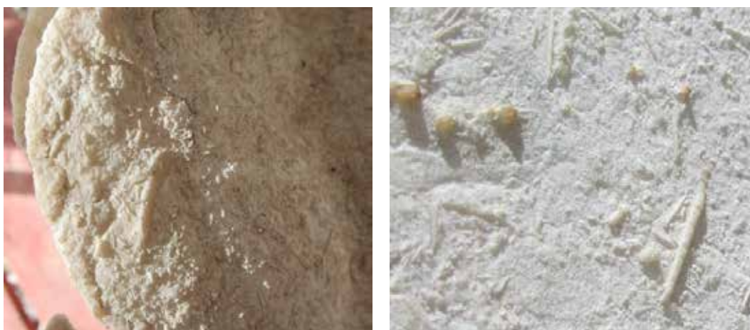
Fig. 2 - Aspecto da erosão causada pela dissolução nos elementos esculpidos. Notem-se os fósseis e os grãos de sílica que, por serem menos solúveis, ficam destacados na superfície do calcário
