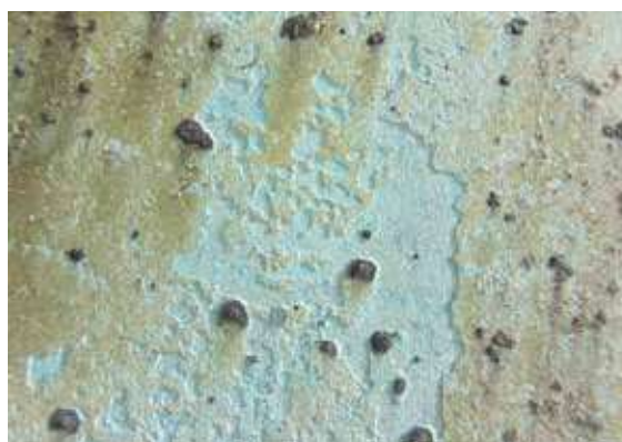
Fig. 16 – Pátina verde. Esquerda: corte esquemático da pátina verde contínua (I) e da pátina verde com pontos pretos (II). Direita: aspeto visual de uma zona com pátina verde e pontos pretos.
