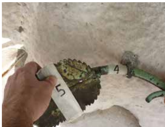
Fig.17 - Ensaio de posicionamento e encaixe de uma das silvas soltas.
