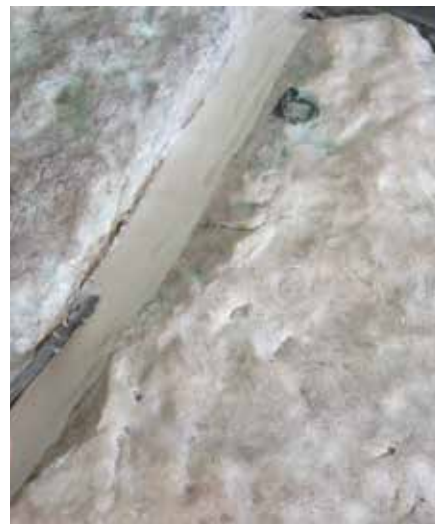
Figs.16 e 17 – Selagem das juntas do topo do plinto com sistema multicamadas.
