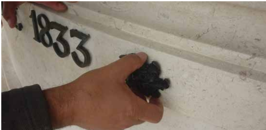
Fig.22 – Recolocação de réplica de um dos florões em falta.
