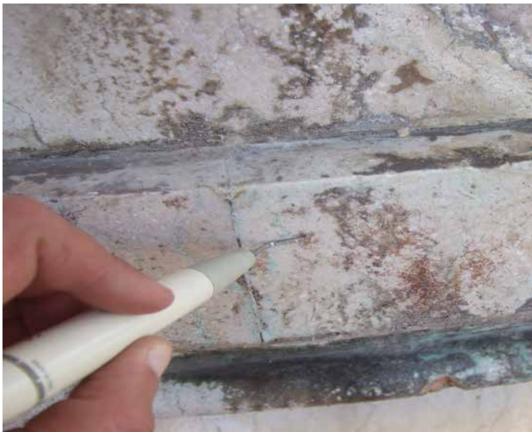
Fig.8 – Limpeza de concreções calcárias com equipamento de ultra-sons.
