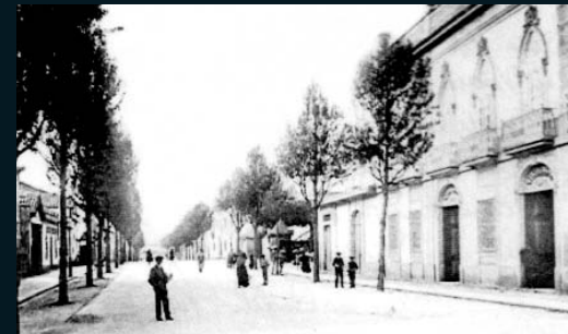
Casa dos avós de Adriana em Viana do Castelo
