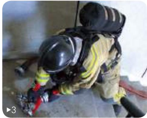
3▶ O **auxiliar** desenrola pelas escadas, no sentido descendente, o lança que transportou. Efetua a união do lança ao disjuntor e verifica se as válvulas do disjuntor estão fechadas.
