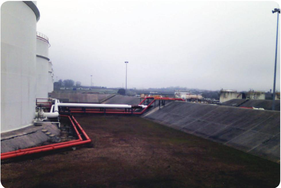
um tanque, este não atinja os tanques vizinhos ou outras instalações. Assim, todas as operações de combate a incêndios devem ser lançadas sobre essas estruturas e nunca de dentro da bacia de retenção, que deve ser considerada neste caso como uma zona de risco.
